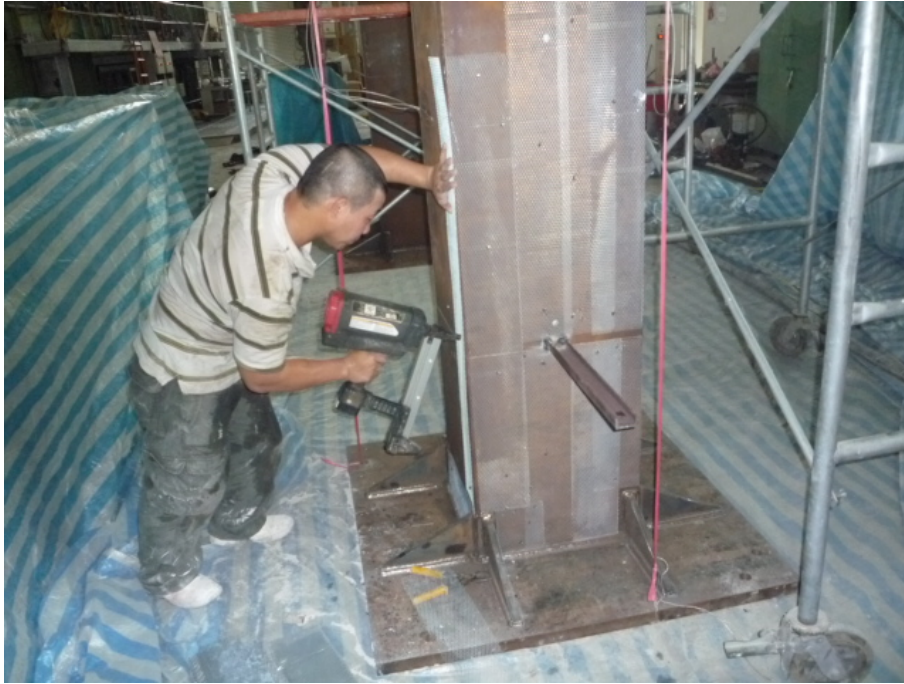
圖 3-7 鋼網施工
