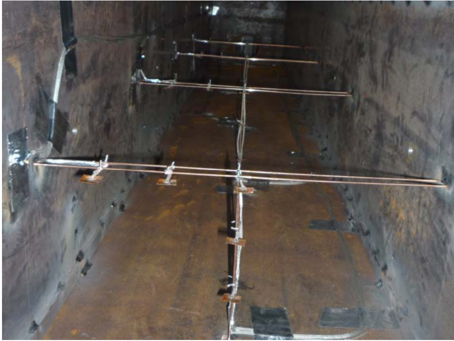
圖 3-3 CFBC 試體內部熱電偶測點安裝圖
