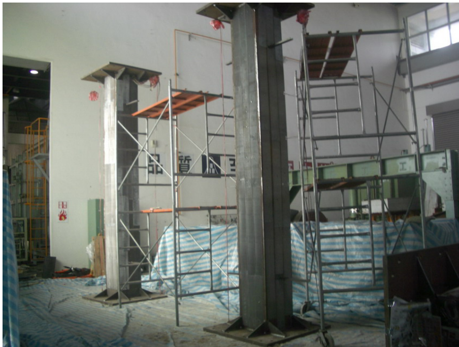
圖 3-8 鋼網鋪設完成圖
