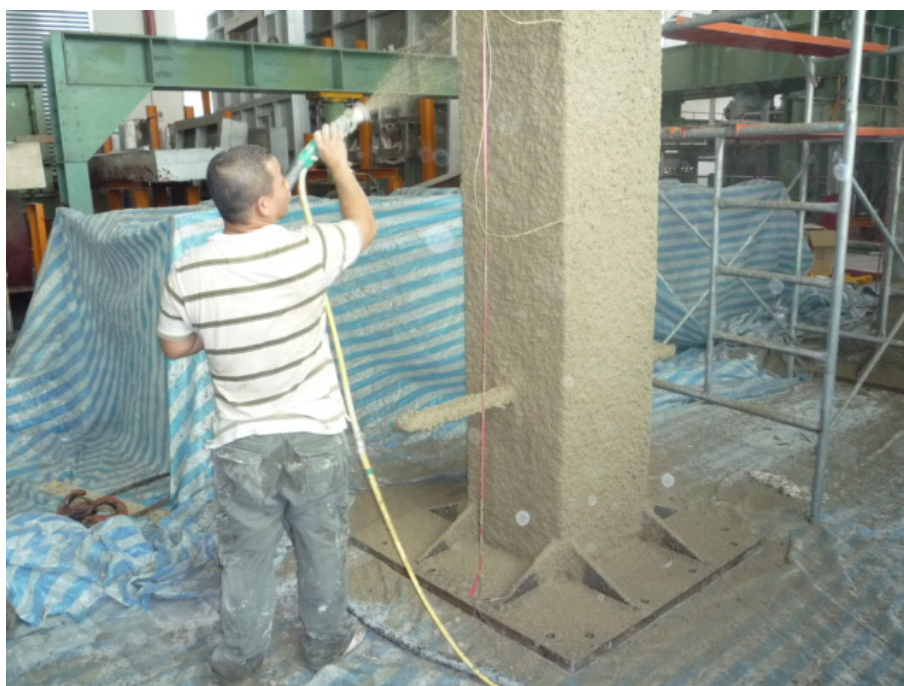
圖 3-10 CFBC 試體防火被覆施工(二)
