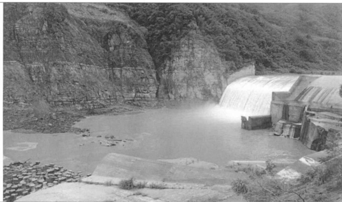
(a) 98.08.05 義興壩下游冲刷形成之冲刷坑。
