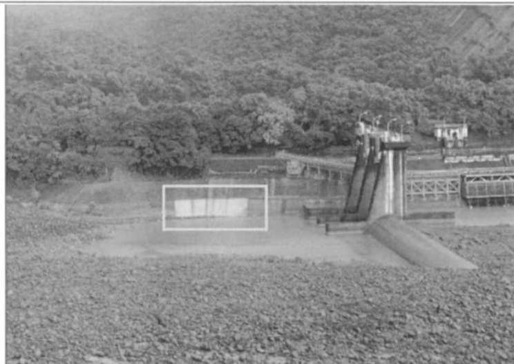
(c) 99.06.28 右岸護岸破損修復
