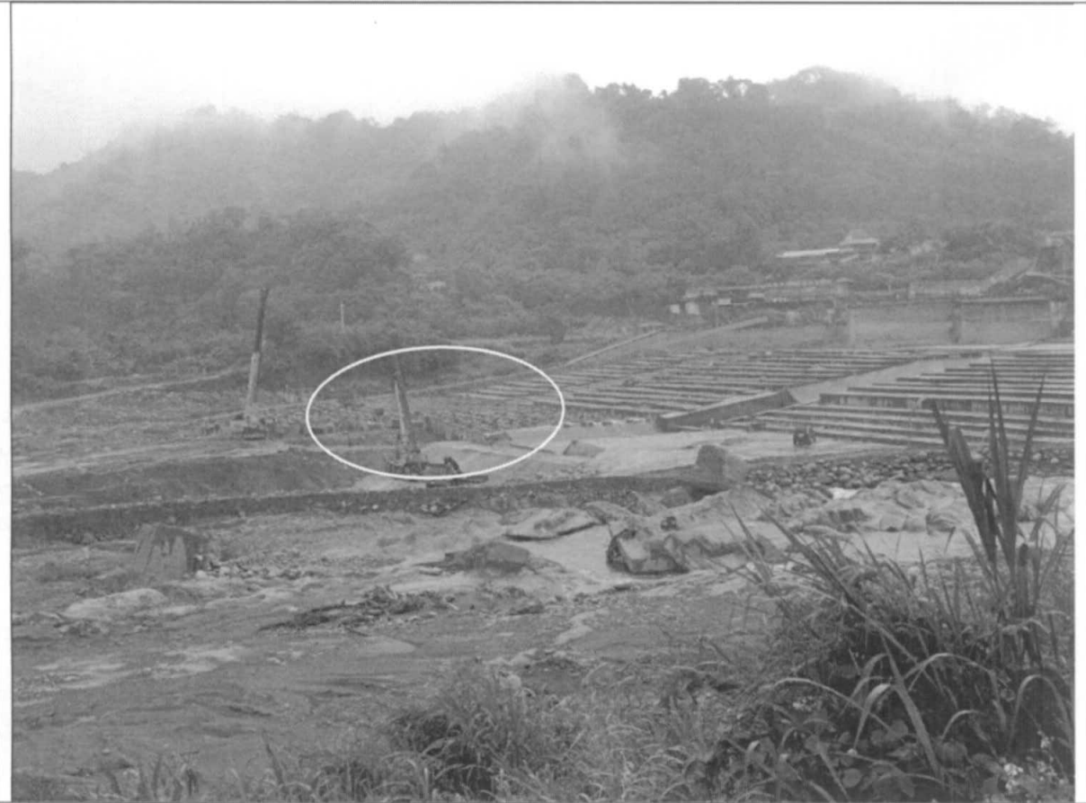
(d) 99.04.23 沖刷坑已完成固床工設施
