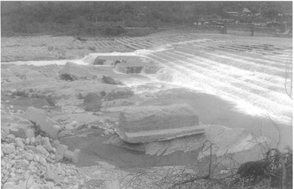
圖 5-7 石岡壩堰前沖蝕狀況
