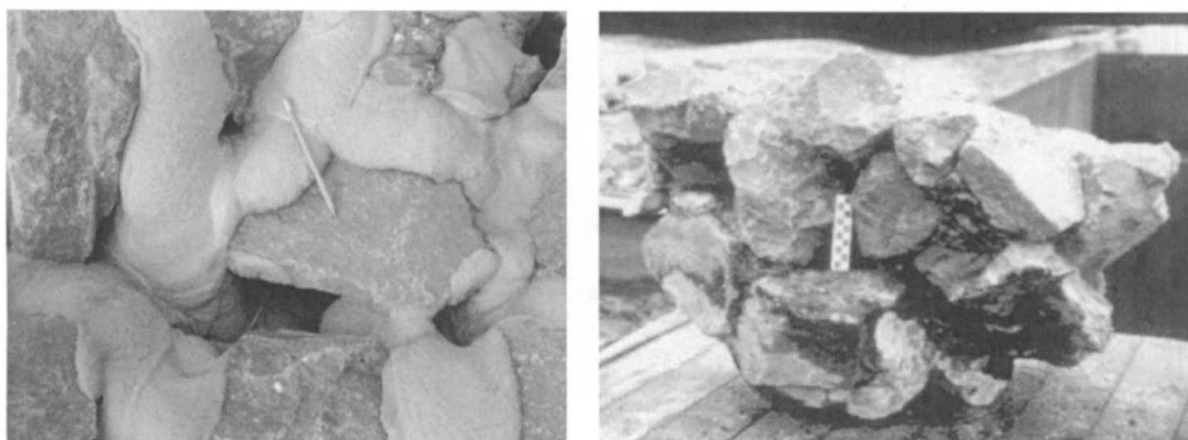
圖 7-1 部分灌漿拋石護層施作方式
