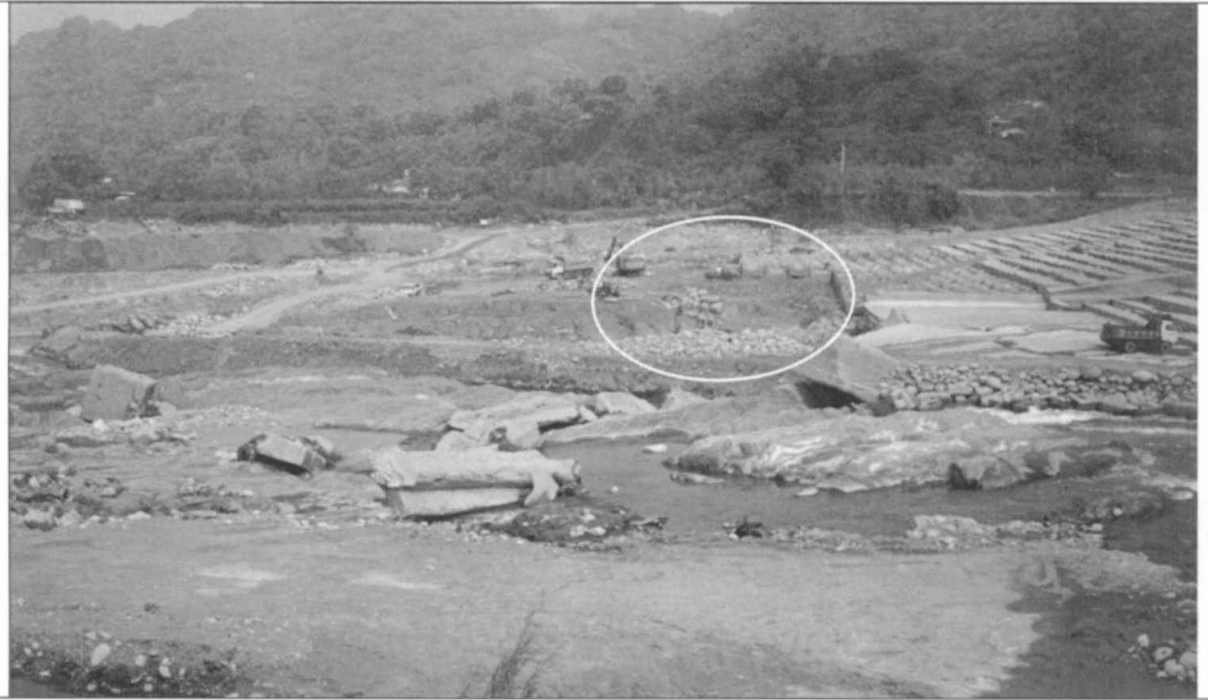
(c) 99.03.22 沖刷坑已因進行壩體下游沖刷改善工程經卵礫土石填覆
