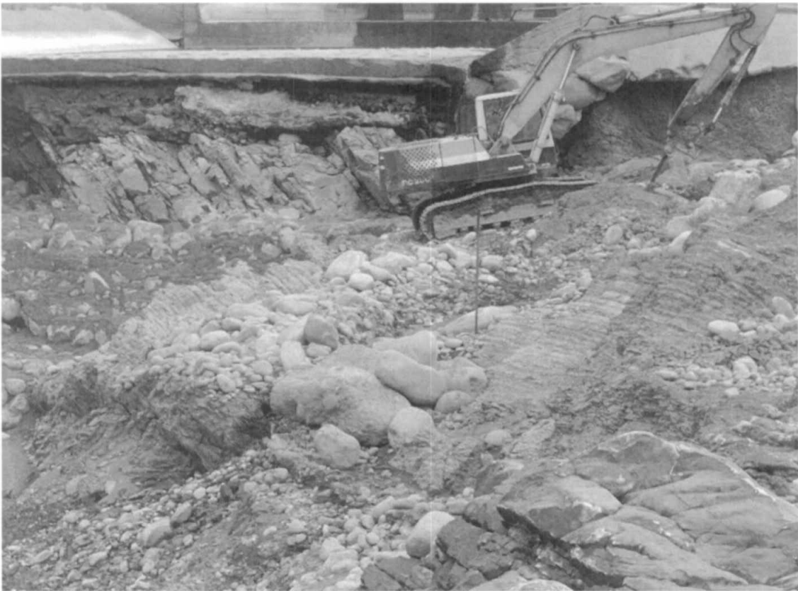
圖 3 - 23 石岡壩堰前層狀砂岩之高傾角傾角且岩層破碎圖
