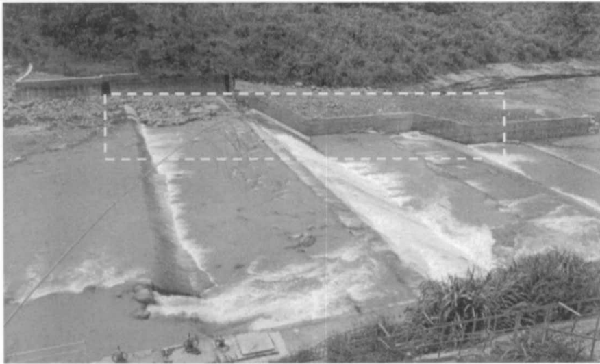
(a) 98.03.03 攔河堰修復
