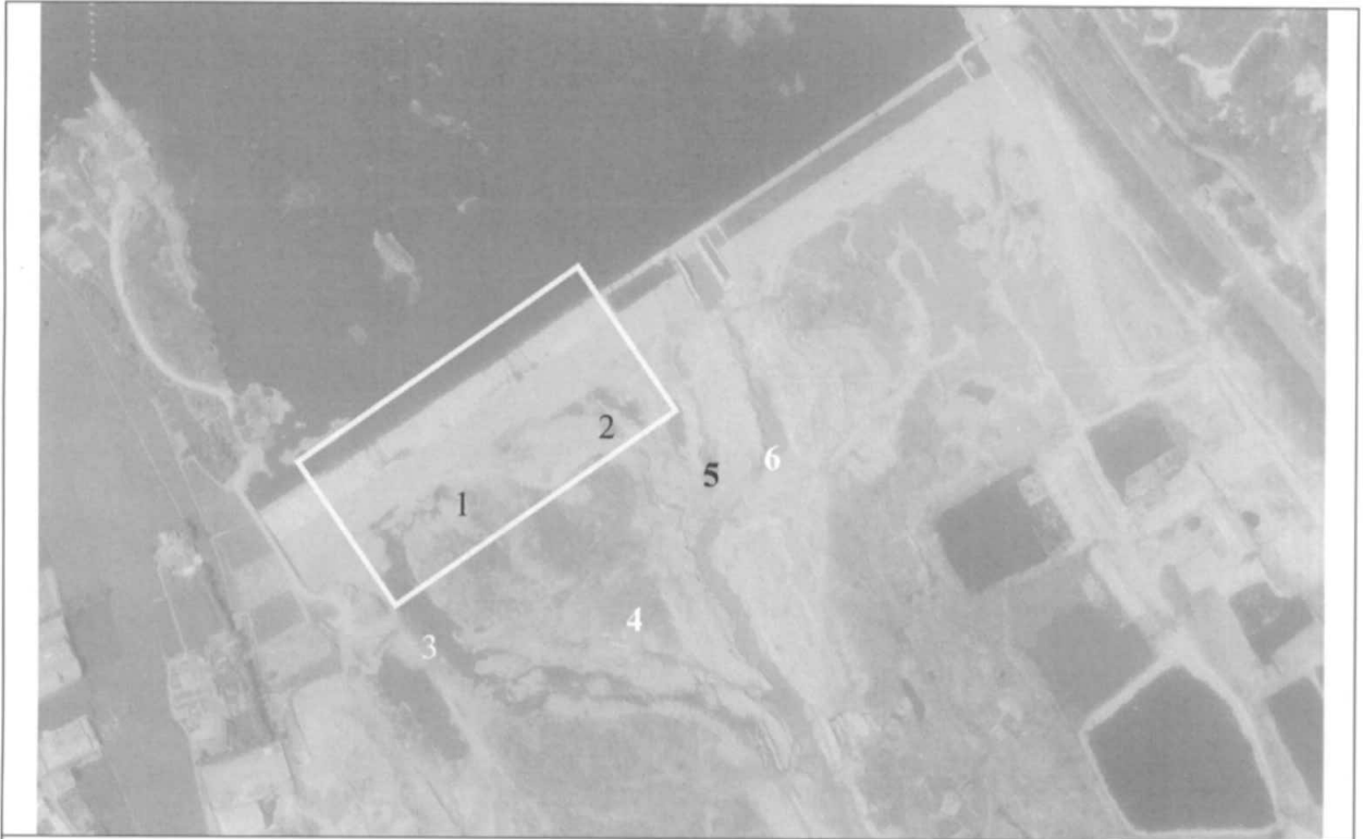
(a) 72.10.22 1~2 為堰前沖刷坑；3~6 為下切之深槽(方框為堰體未沖毀時位置)。
