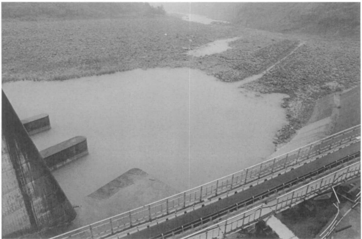
圖 3-61 東口堰堰前沖刷坑
