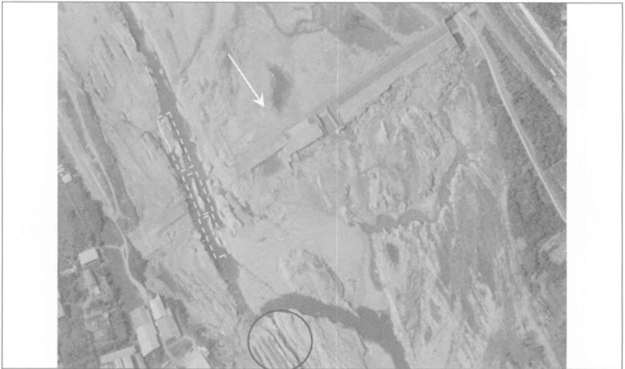
(b) 93.11.07 艾利颱風後。右岸壩體被洪水切穿，砂岩矗立河道(虛線方框處)，堰址下游亦可看出有槽狀河溝之情形(圓圈處)。
