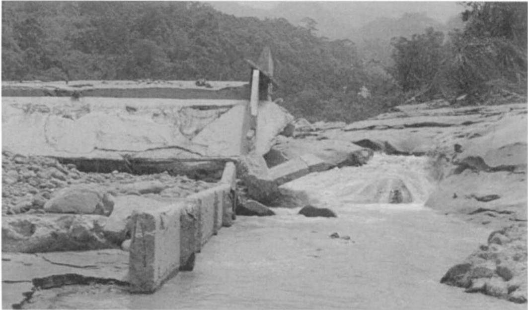
圖 3 - 51 觸口攔河堰莫拉克颱風後堰外左側改道下切狀況
