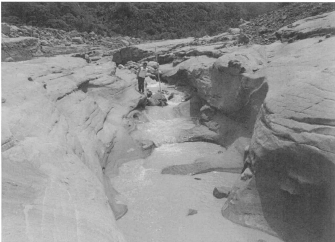
圖 3 - 52 觸口堰堰體左岸切穿與壺穴沖蝕
