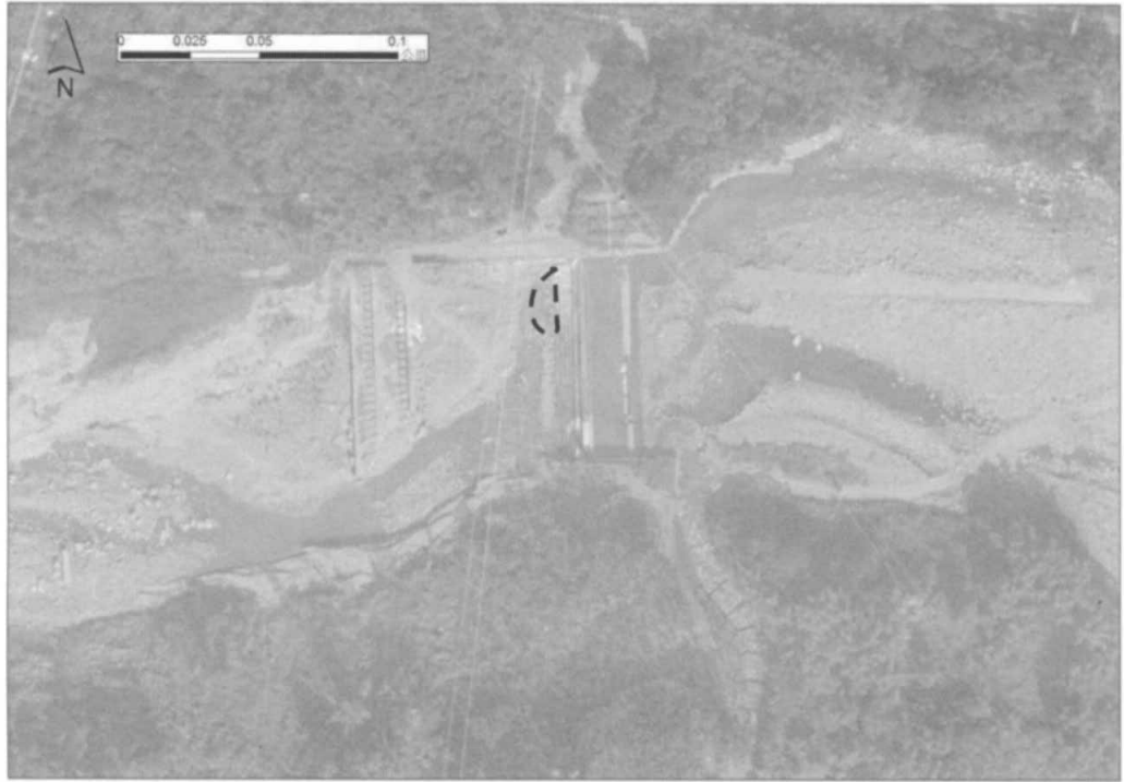
(b) 94.11.27 下游固床工部分沖毀，堰下游固床混凝土塊流失，沖刷坑形成(圖中虛線處)。
