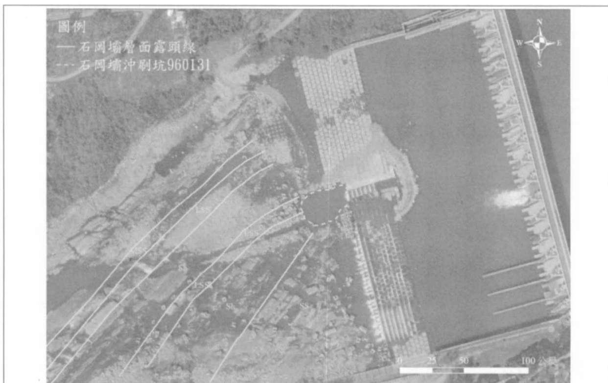
(a) 96.01.31 堰前階梯式消能工前有橫向沖刷坑，下游固床鼎型塊沖毀，中央開始有較大的沖刷坑出現。
