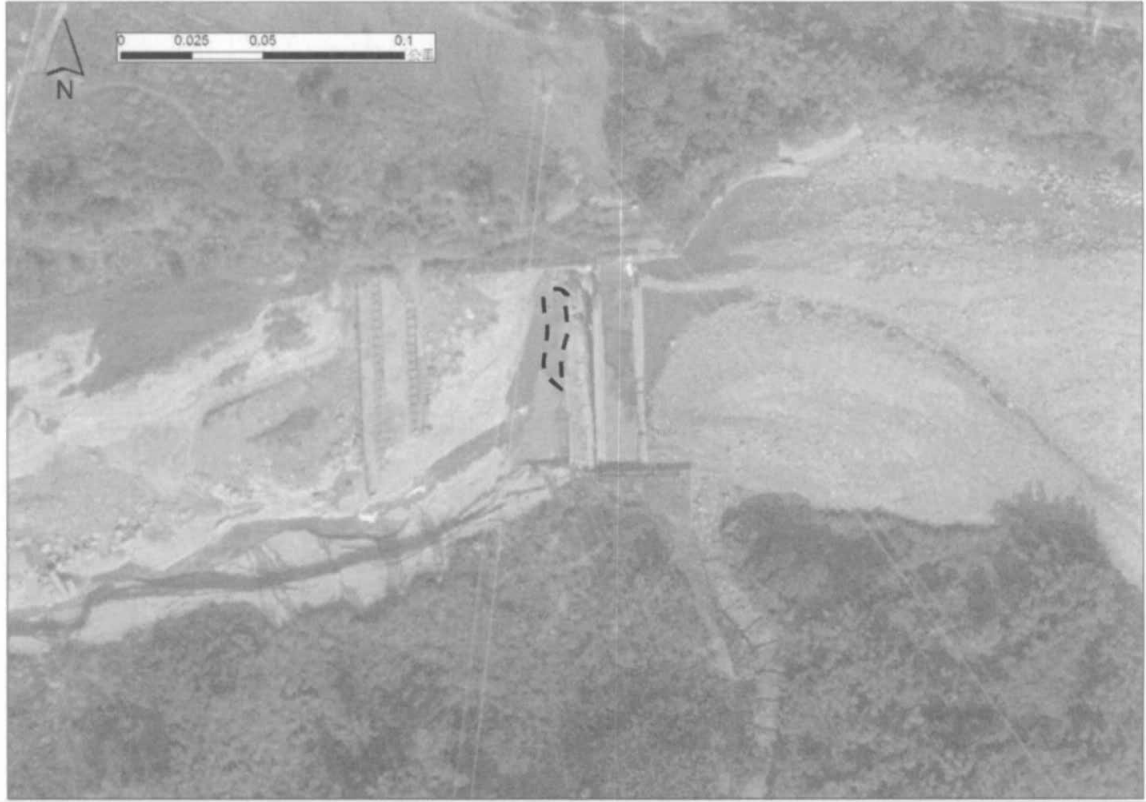
(c) 96.02.03 堰前消能設施沖毀，沖刷坑擴大(圖中虛線處)。
