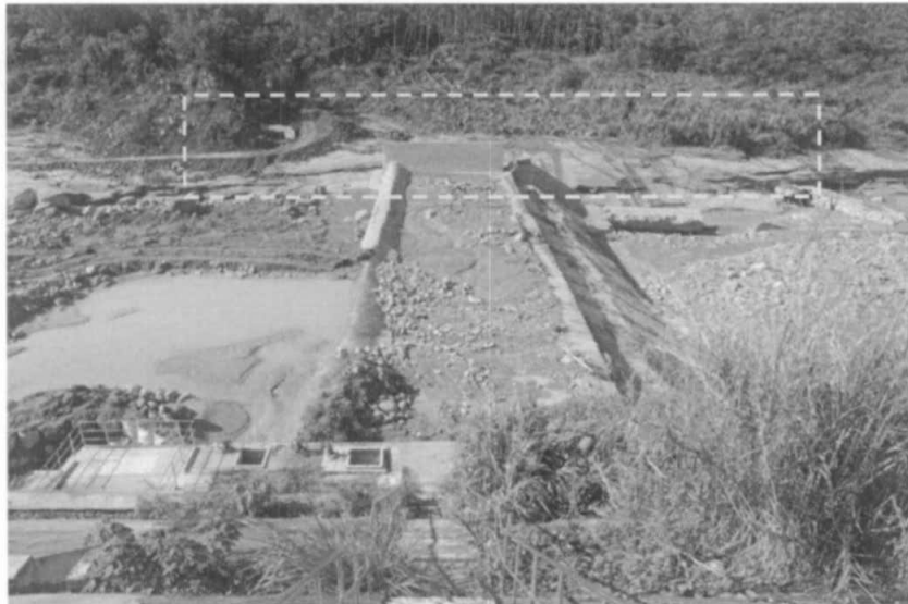
(c) 99.05.01 左岸新河道無太大變化，土石漸淤積於堰體上
