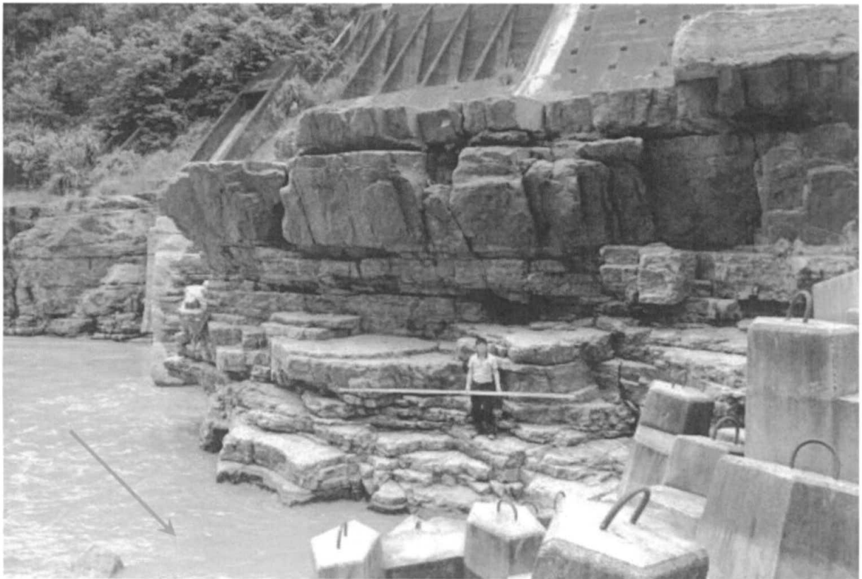
圖 5-5 義興壩下游節理發達岩體沖蝕狀況
