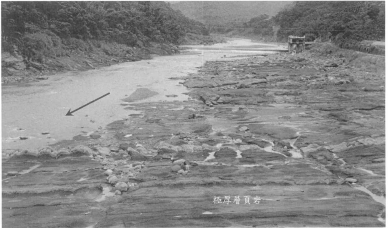
圖 5-10 龍泉圳攔河堰下游出露頁岩及沖蝕狀況
