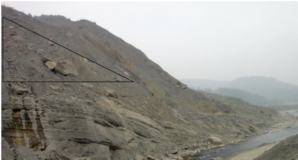
圖 7-11 主要壩體下游坡面坡面 1(H) : 2(L)
