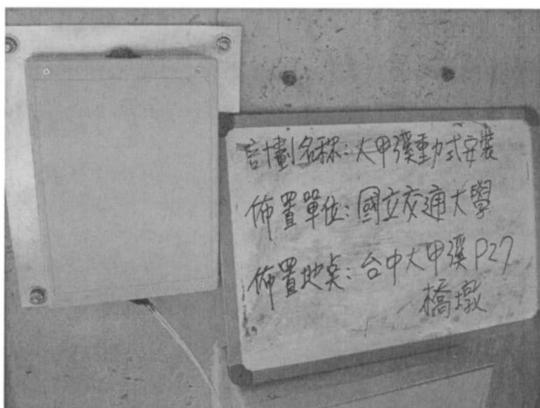
圖 3.26 FBG 測傾儀安裝完成圖
