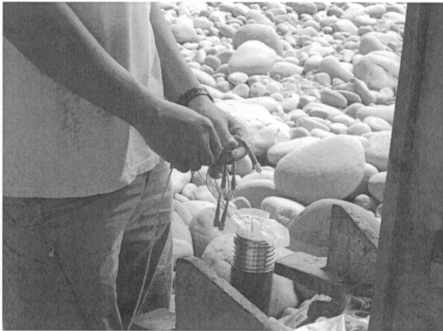
圖 3.12 現地水壓計鑽孔內安裝
