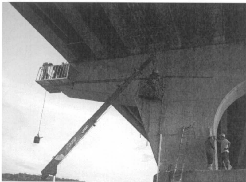
圖 3.21 光纜架設施工圖
