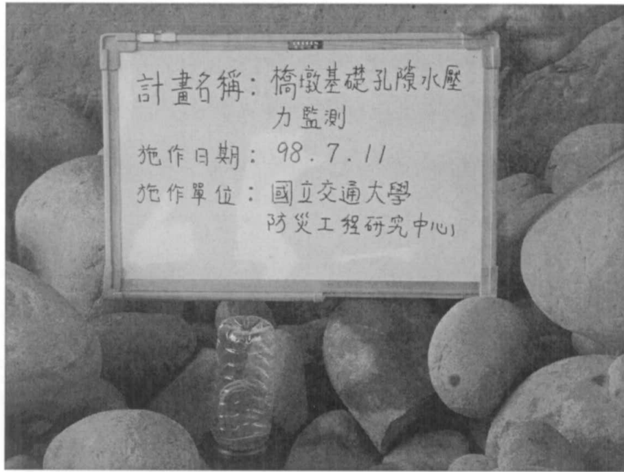
圖 3.13 現地水壓計鑽孔內安裝完成
