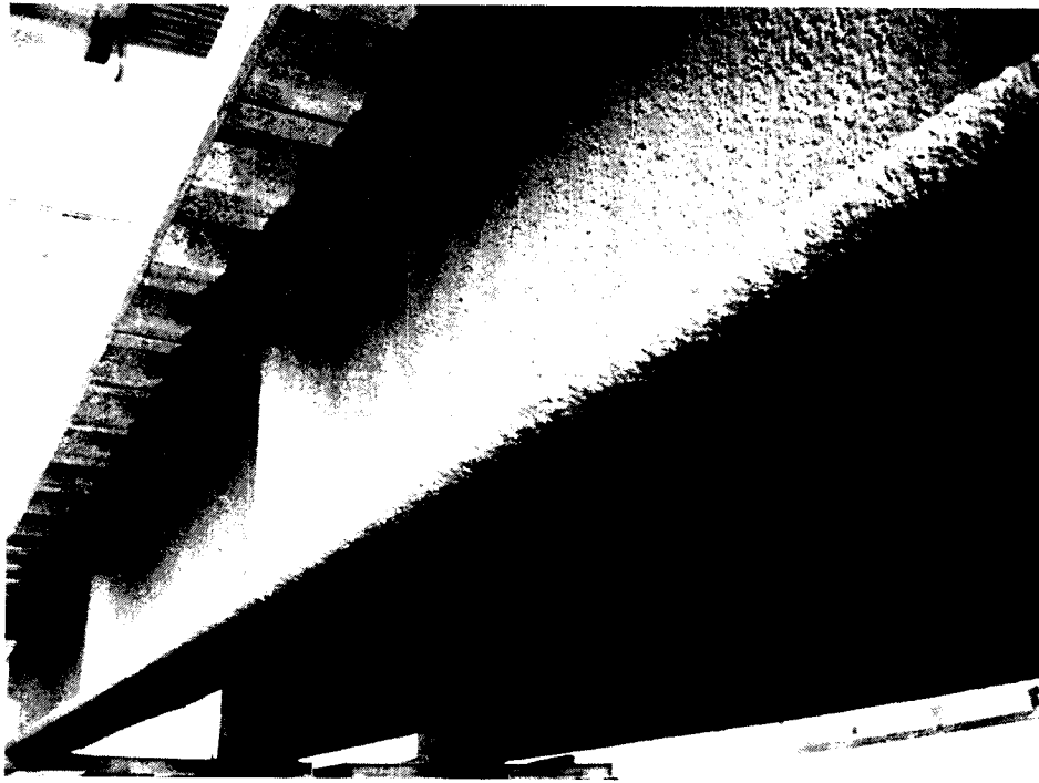
圖 3-13 鋼梁防火被覆完成施工
