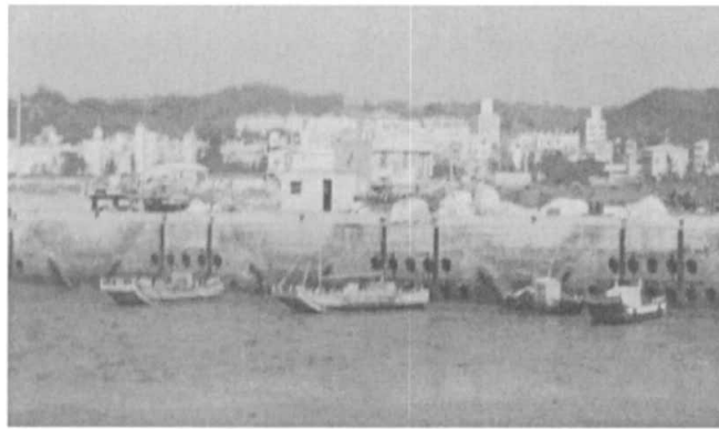
圖 4.3 具孔洞的重力式碼頭
