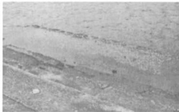
花蓮港防波堤排水凹槽
