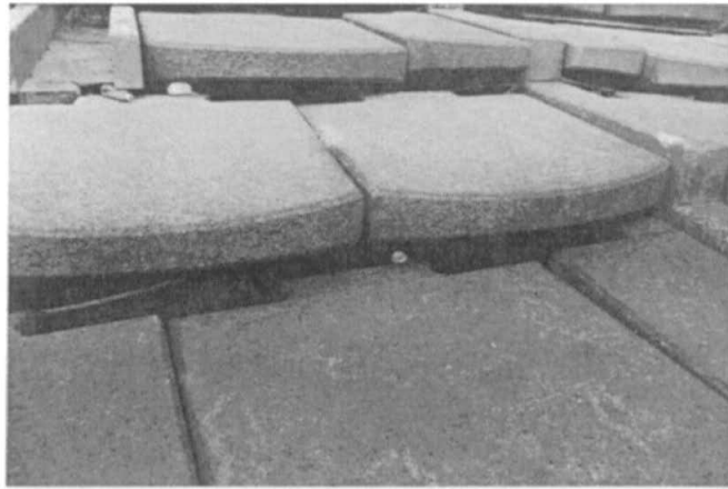
圖 4.13 階梯式護岸具有透水孔隙
