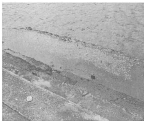
圖 4.67 花蓮港防波堤排水凹槽
