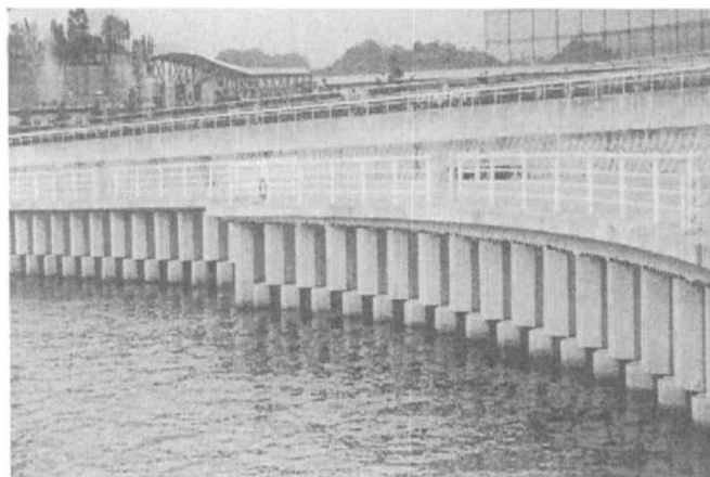
圖 4.12 直立開孔式混凝土護岸
