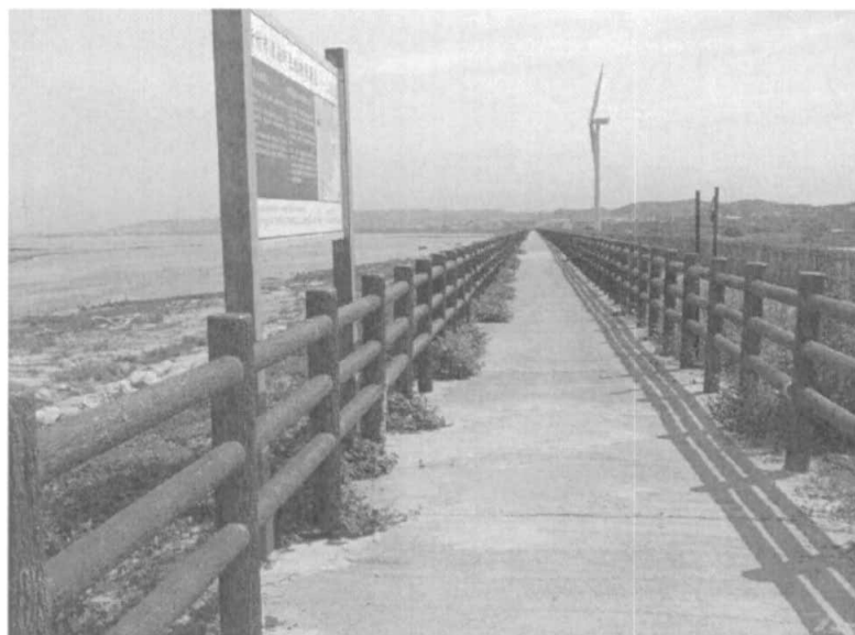
圖 5.41 海堤上設置自行車道
