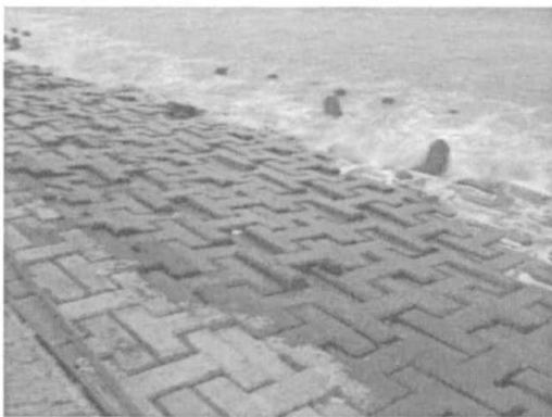
圖 4.37 旗津海岸護坡
