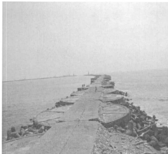
圖 5.52 港口防波堤稍做改善即可成為良好的釣魚場所(高雄港)
