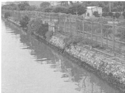
圖 4.23 第五船渠 護岸
