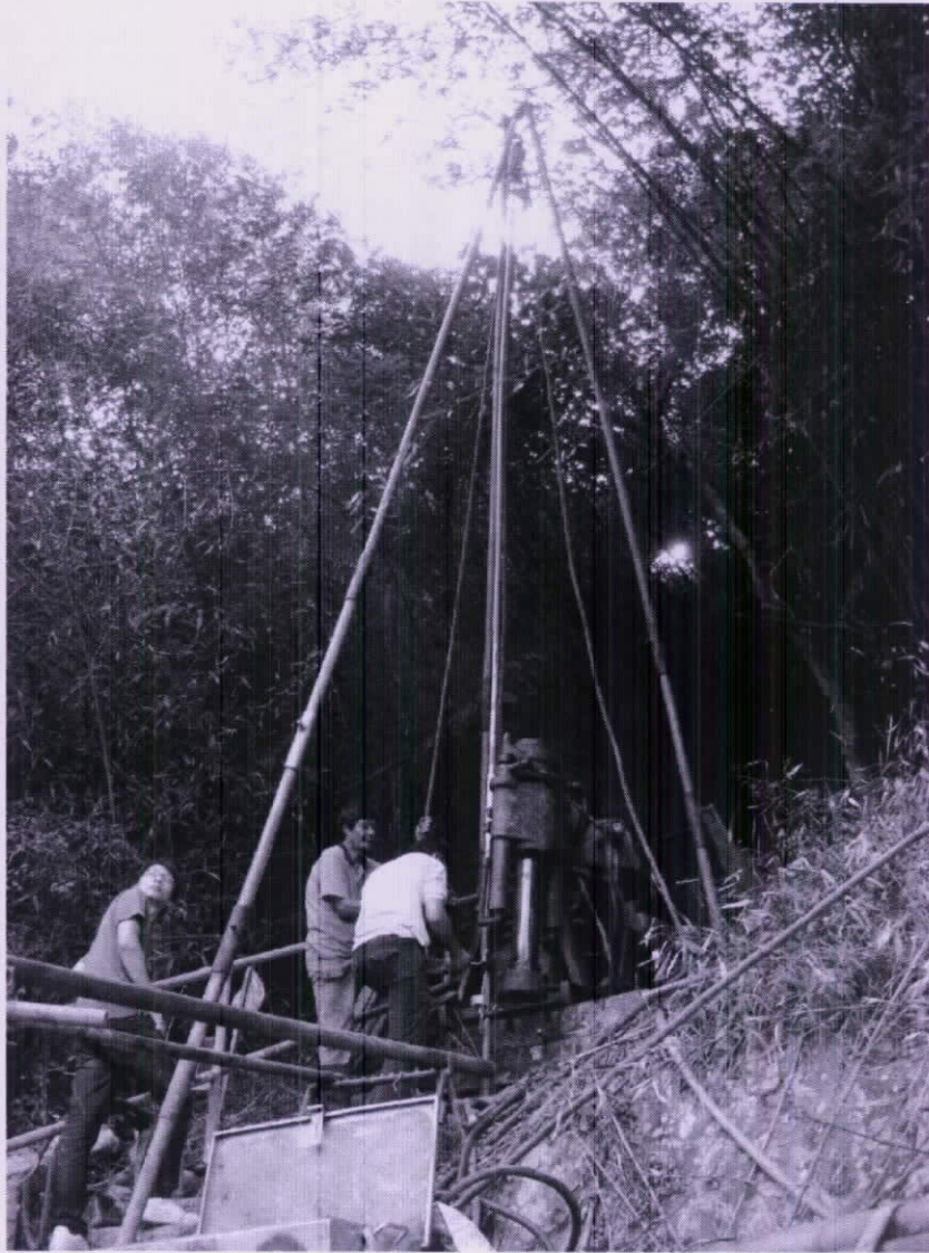
圖 2.69(d) 以三角架吊起 5 米長光纖光柵水壓計
