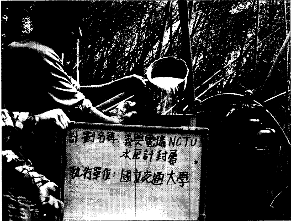
圖 2.69(i) 水壓管回填封層
