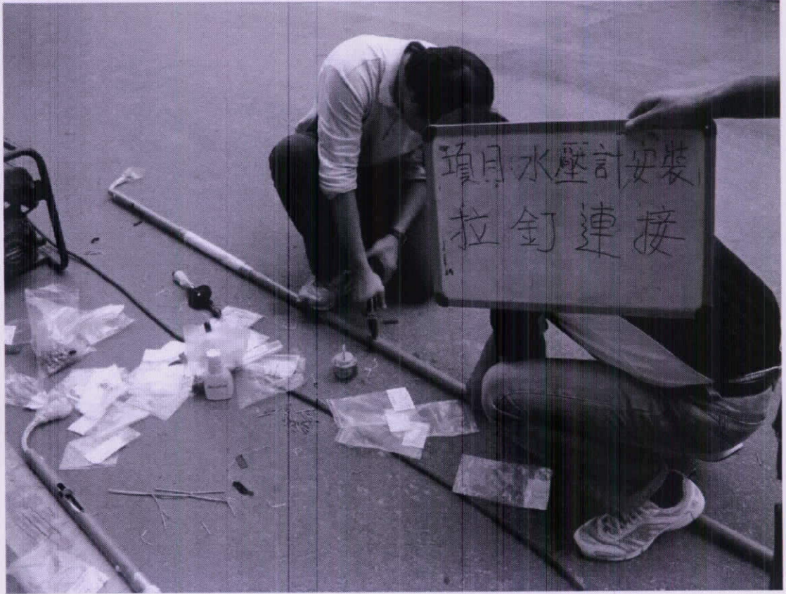
圖 2.69(c) 現地 5 米內拉釘連接
