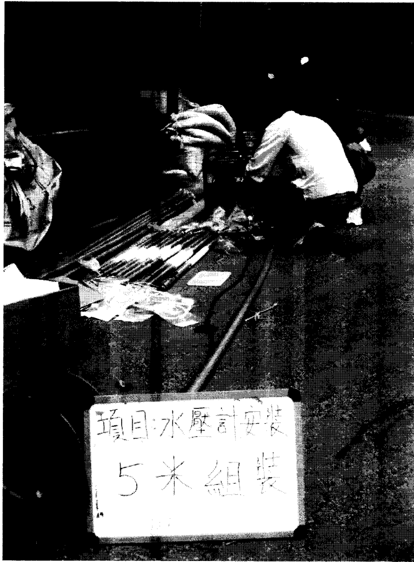
圖 2.69(b) 現地 5 米 PVC 管組裝
