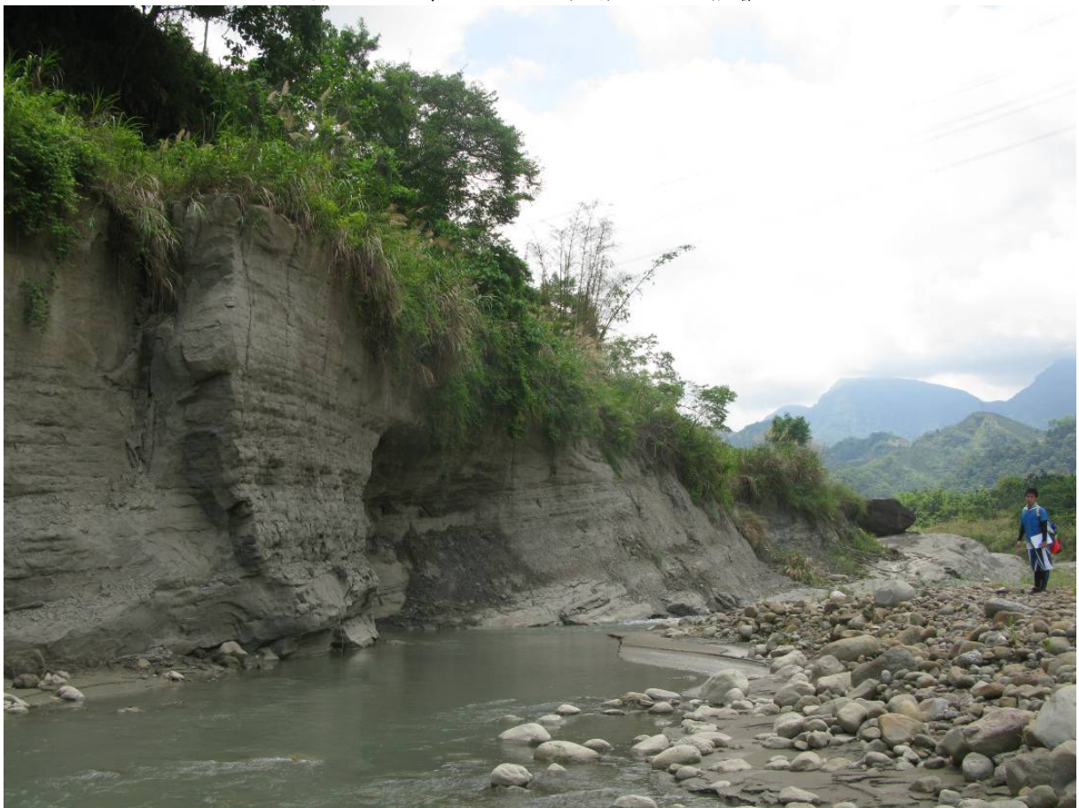
圖 72 八掌溪—坡趾沖刷造成邊坡的崩落破壞
