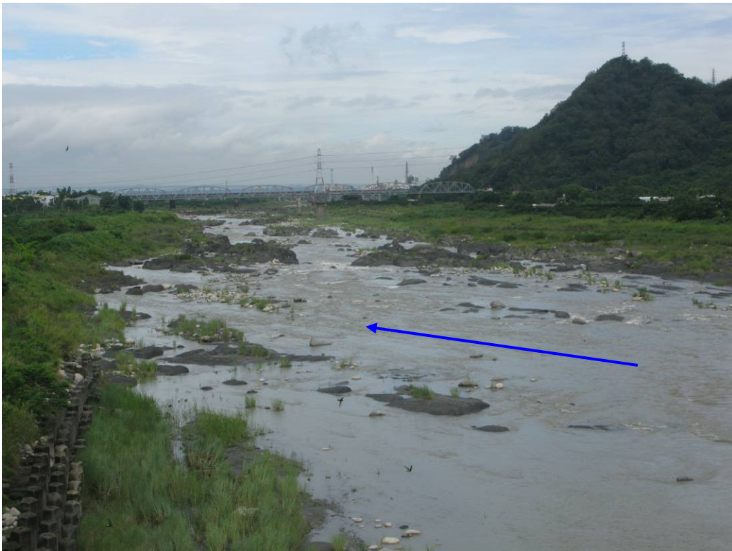
圖 18 大甲溪埤豐橋下游河道沖蝕狀況
