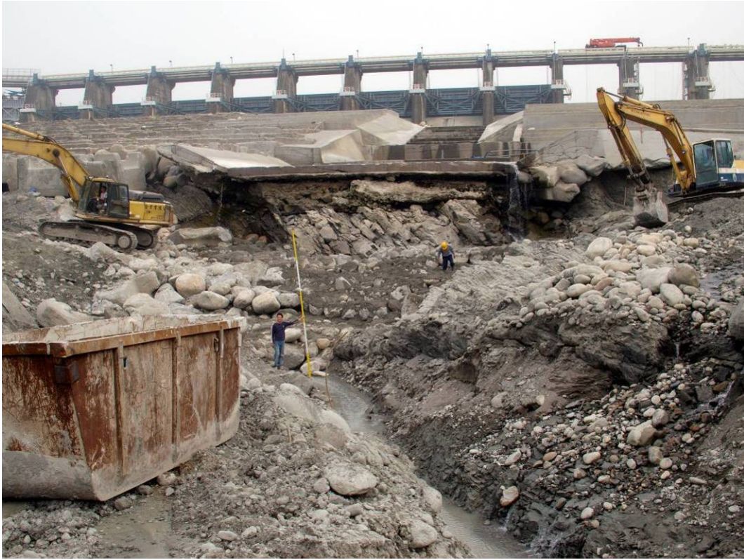
圖 17 大甲溪石岡壩下游河道沖蝕狀況
