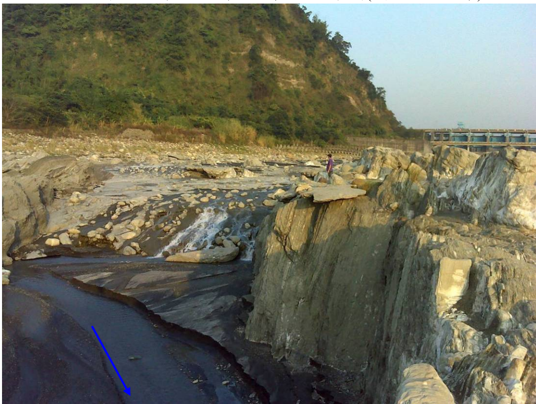
圖 20 濁水溪集集堰下游河道沖刷狀況
