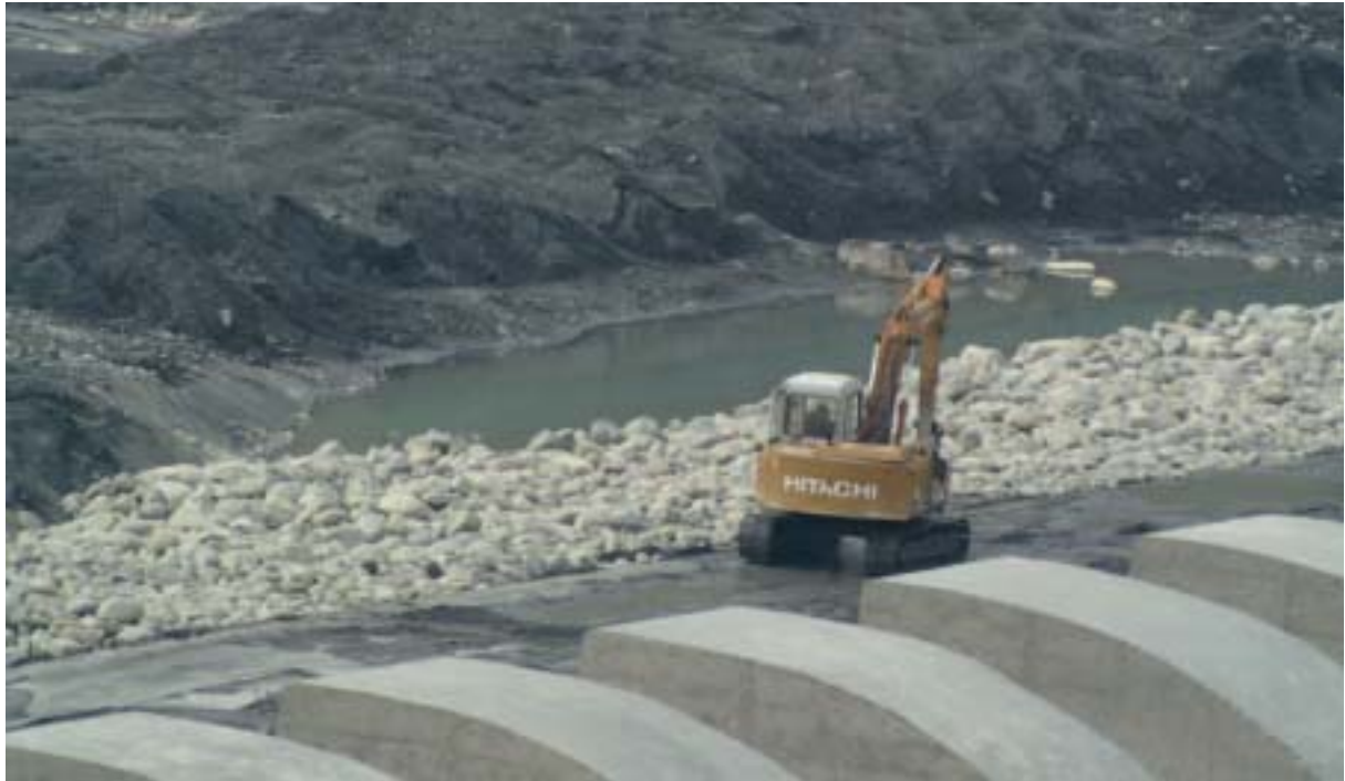
圖 3-30 集集攔河堰護坦前鋪設礫石作業(97年3月)
