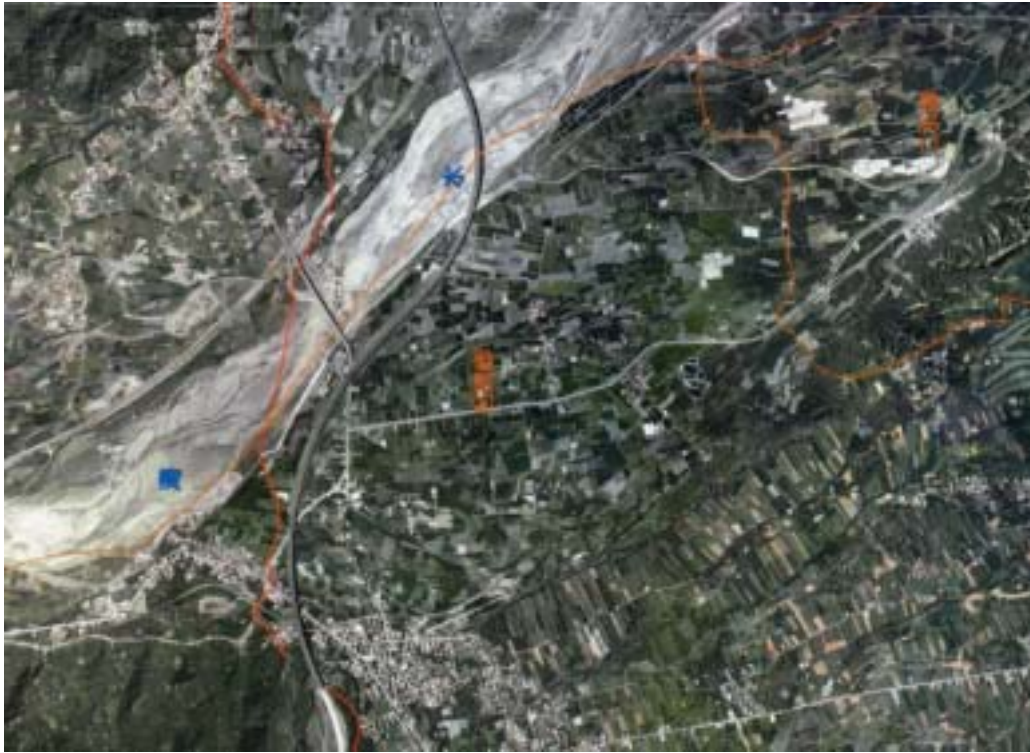
圖 2-48 921 地震破裂帶通過名竹大橋 (摘自農航所「震痕」)
