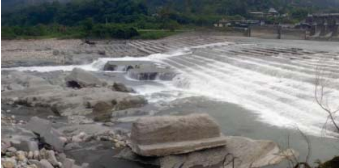
圖 5-10 石岡壩堰前沖蝕狀況
