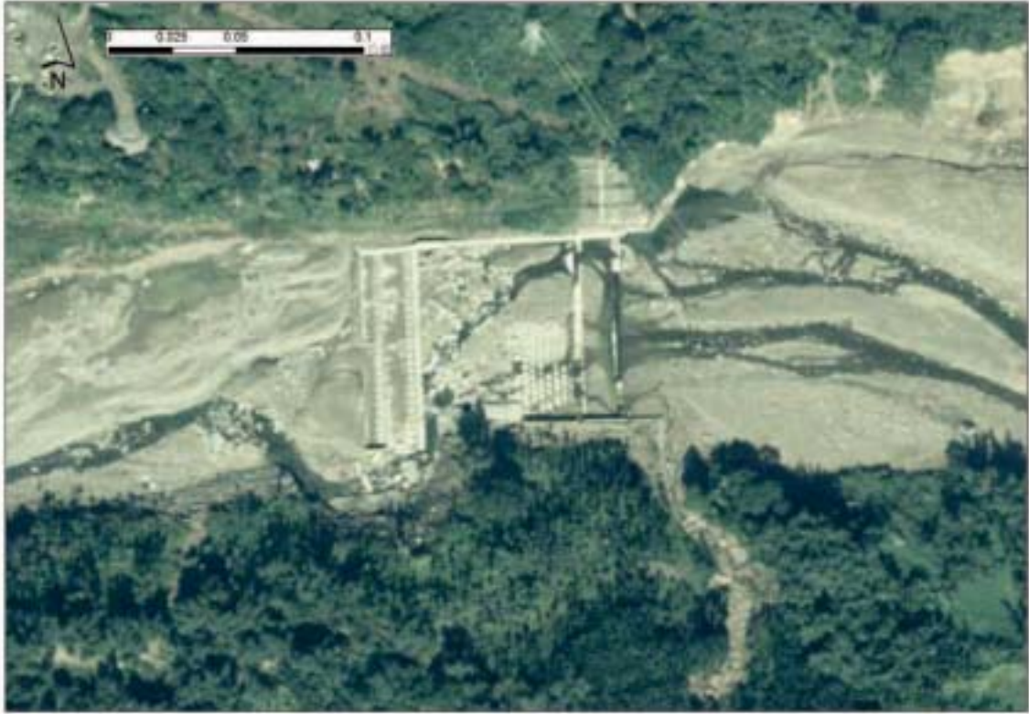
圖 2-59 觸口攔河堰 90 年 11 月 17 日航空照片
