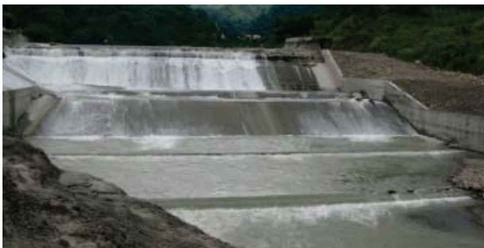
圖 2-56 觸口攔河堰修復狀況照片(98.7.14)
