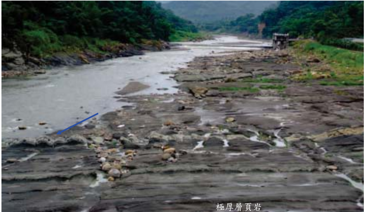
圖 5-14 龍泉圳攔河堰下游出露頁岩及沖蝕狀況
