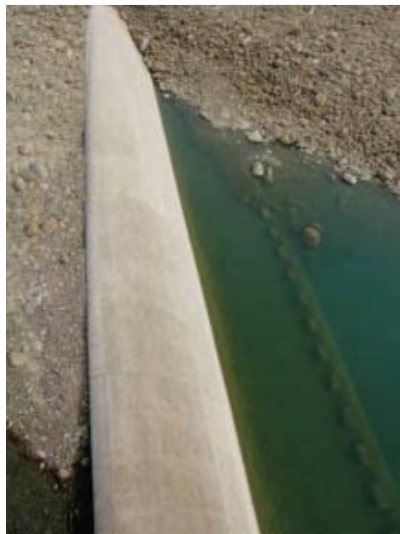
圖 2-65 東口堰下游設置之消能池
