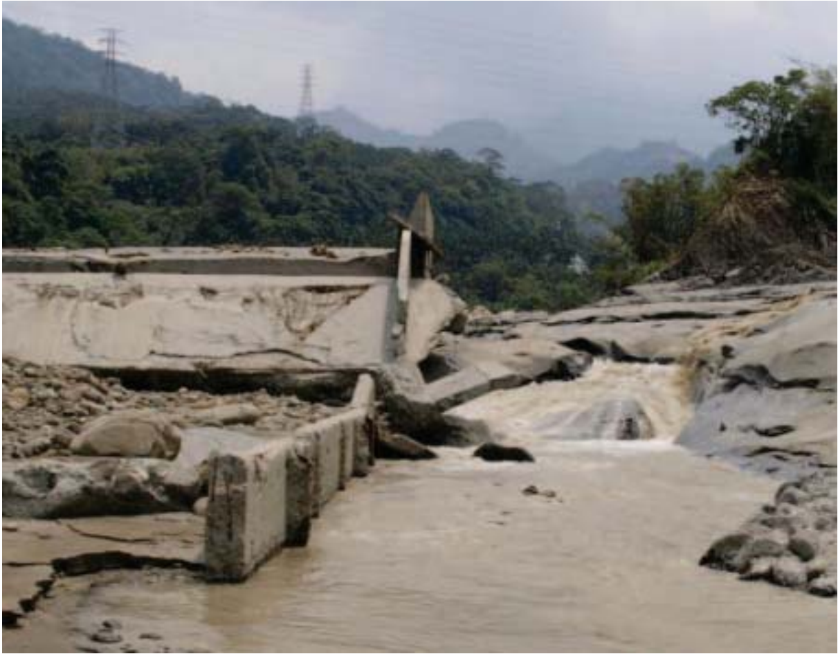
圖 3-35 觸口攔河堰莫拉克颱風後堰外左側改道下切狀況
