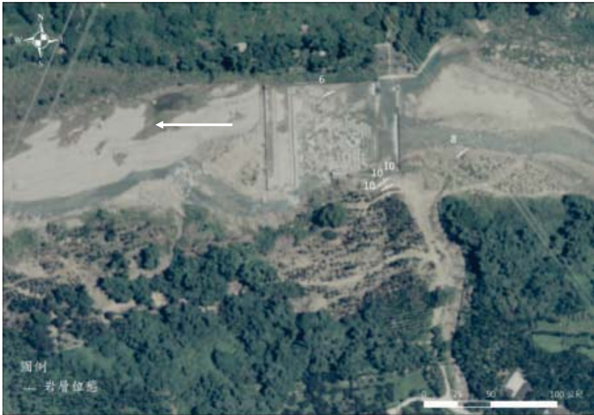
圖 3-32 觸口攔河堰地表露頭量測點
