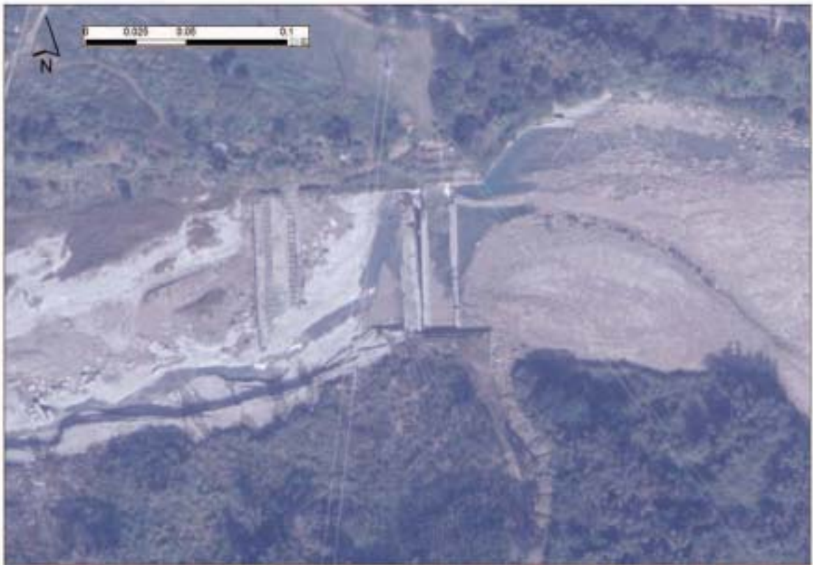
圖 2- 62 觸口攔河堰 96 年 2 月 3 日航空照片
