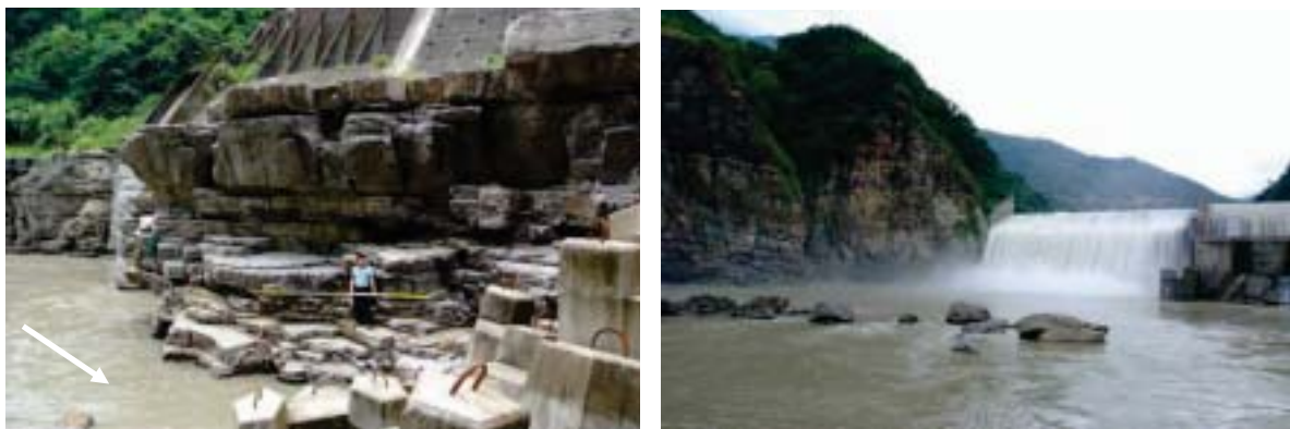
圖 5-8 義興壩下游節理發達岩體沖蝕狀況
