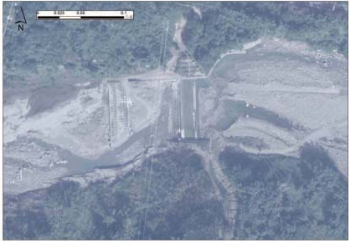
圖 2- 61 觸口攔河堰 94 年 11 月 27 日航空照片
