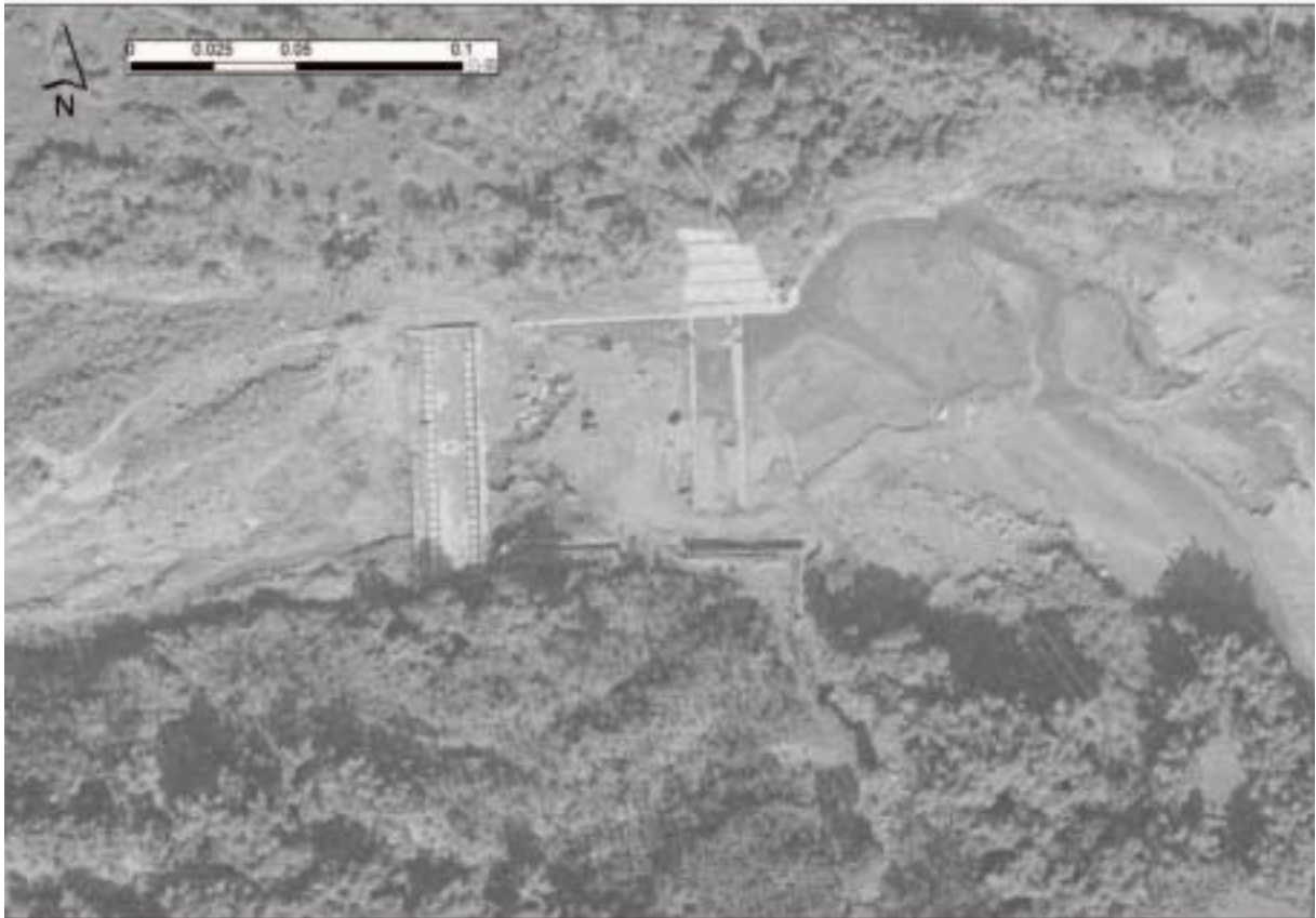
圖 2-58 觸口攔河堰 88 年 12 月 24 日航空照片
