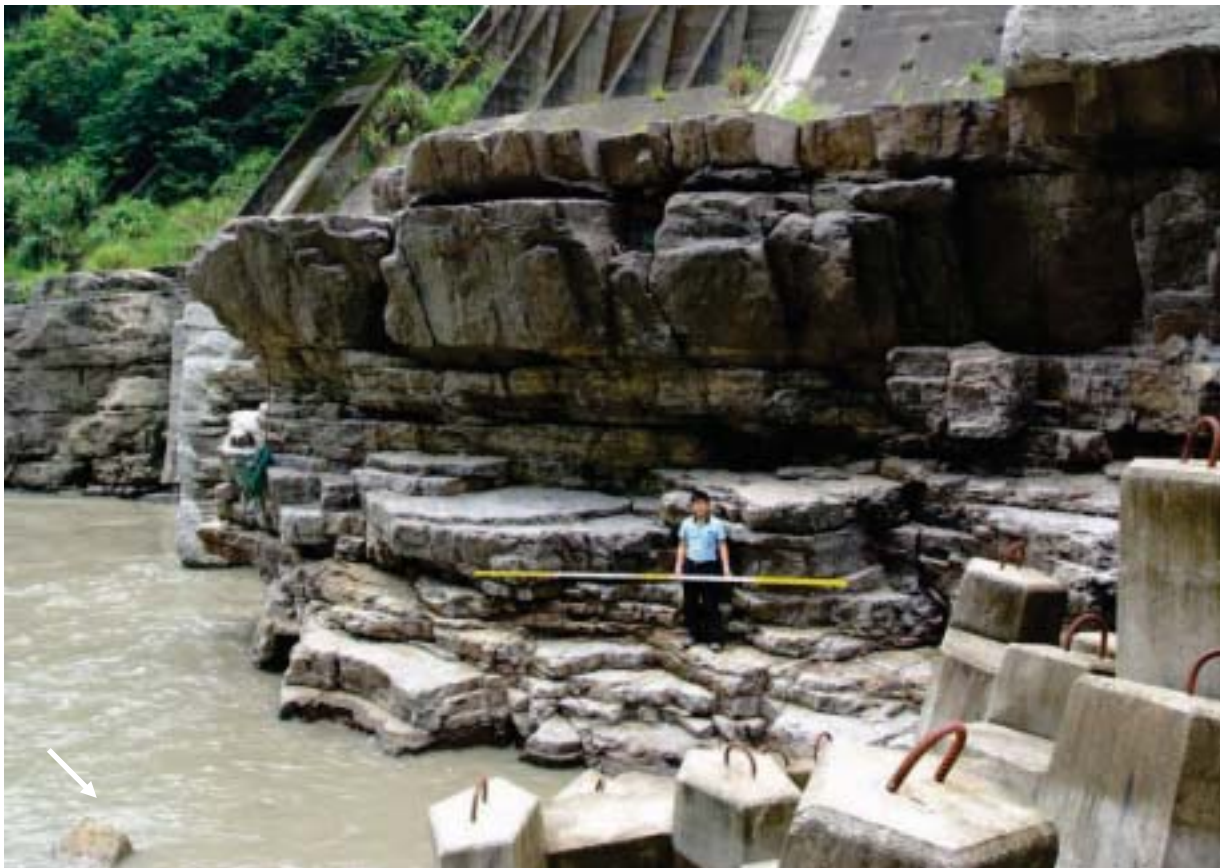
圖 3-12 塊狀砂岩與砂頁岩互層沿節理面及層面之沖蝕狀況
