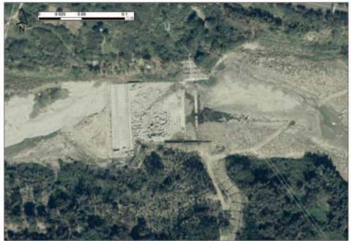
圖 2-60 觸口攔河堰 92 年 3 月 3 日航空照片
