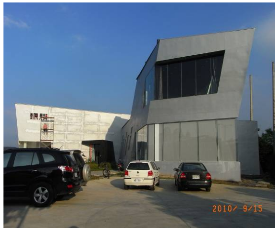
圖 3-18 惠友建設投資高鐵站前 Eco-City 體驗展示館
