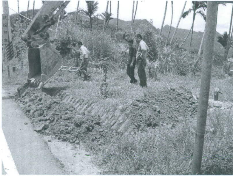
圖 2.11 IHMT-01 孔位光纜佈放工程
