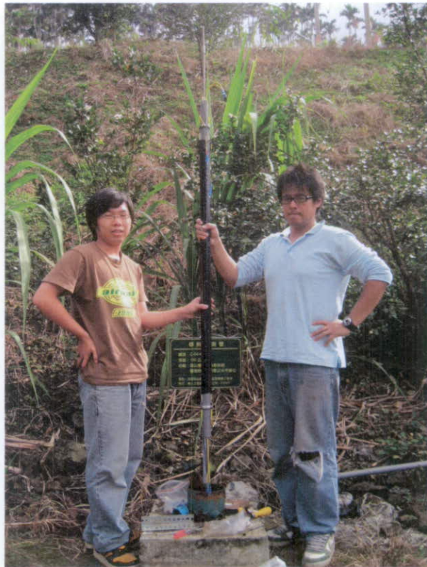
圖 4.14 改良式 BOTDR 拉伸計現場安裝
