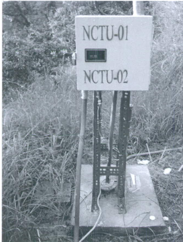
圖 2.16 NCTU-01 及 NCTU-02 光纜架設
