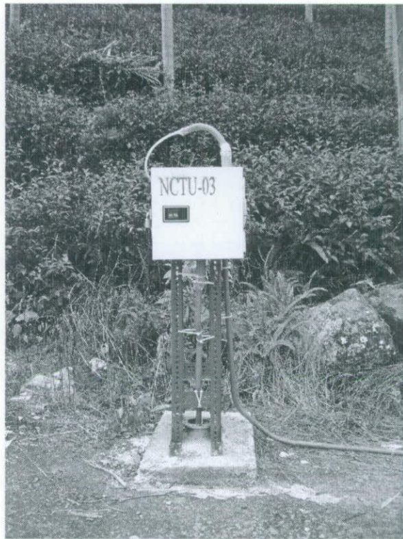
圖 2.17 NCTU-03 光纜架設
