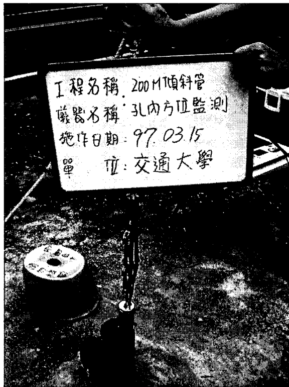
探管置入傾斜管
