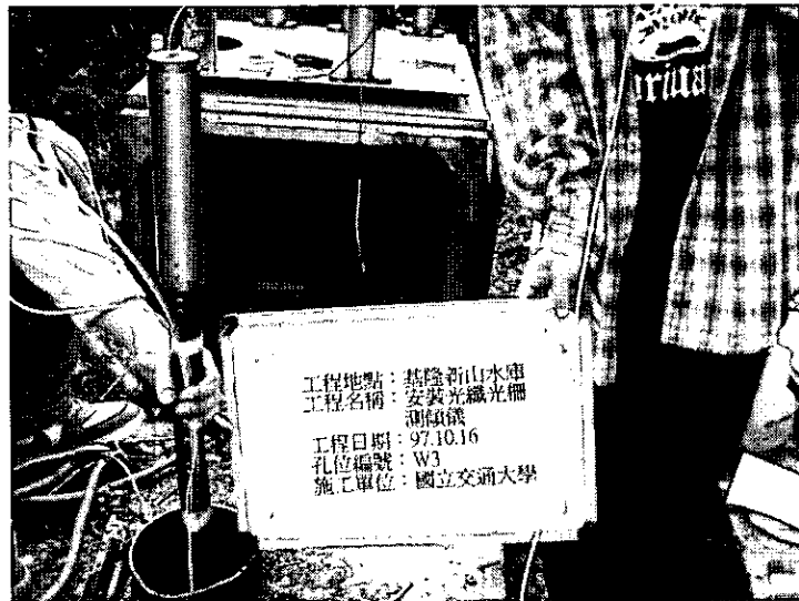
圖 4.67 光纖光柵測傾儀現地安裝圖
