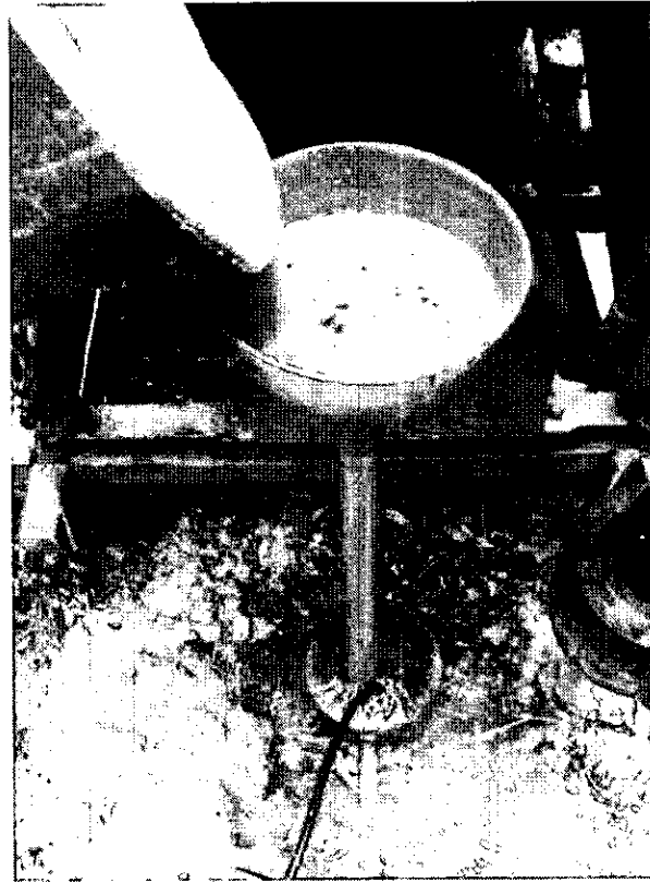
圖 4.83 自 PVC 管中灌入水泥漿
