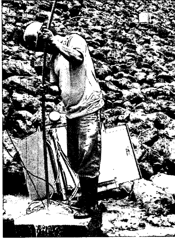
圖 4.53 新山水庫現場清洗水位孔
