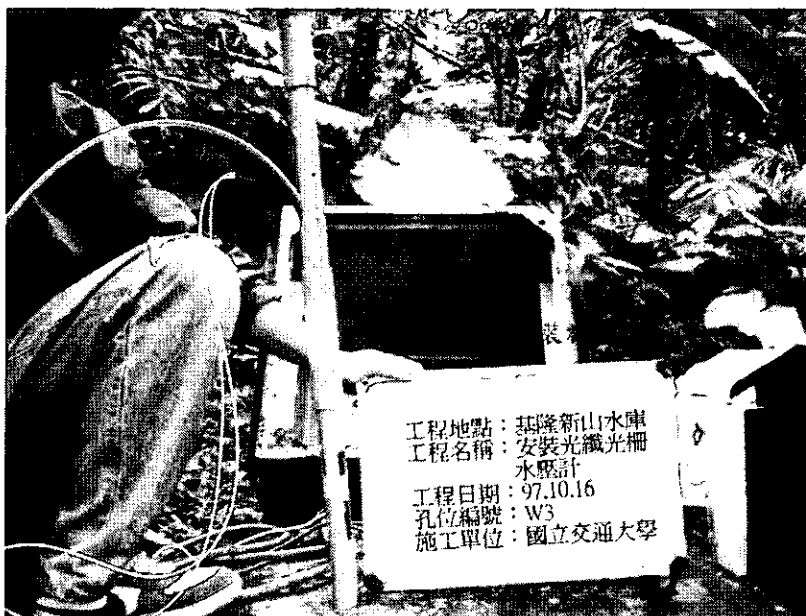
圖 4.68 光纖光柵水壓計現地安裝圖
