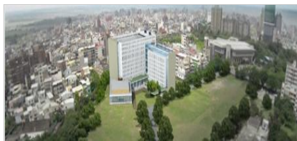
前瞻跨領域生醫工程大樓主體預計於2016年底完工
