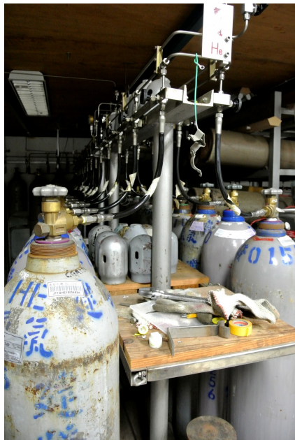
由於氮氣難以取得，因此所有使用過的氮氣都會在液化工廠內回收並保存於鋼瓶內，以維持低溫狀態。（賴儀／攝）
