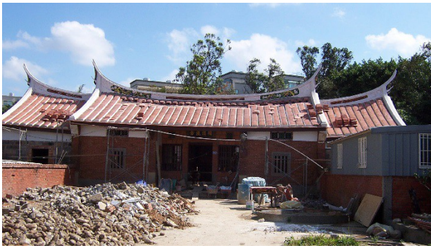
整修中的范姜祖堂，是一棟具有客家樸實特色的建築，整體建築呈口字形。(林詩雯/攝)
