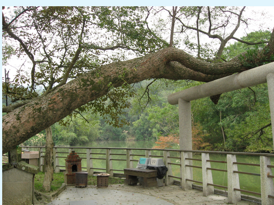
在三叉埤旁，社區用「烏居工法」支撐傾斜的老樹，防止它壓垮左下方的石板伯公廟。(林需楨/攝)
