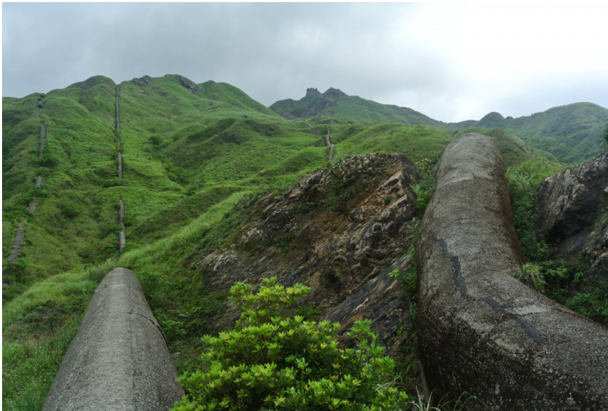
排放煉礦廢氣的排煙道已年久失修，如同巨蛇般蜿蜒在陡峭的山頭。（照片來源／黃吏玄攝）
