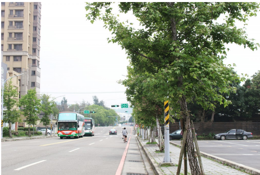
轉運站周邊的道路拓寬綠化，並實施人車分流。（照片來源／曾婕茵攝）
