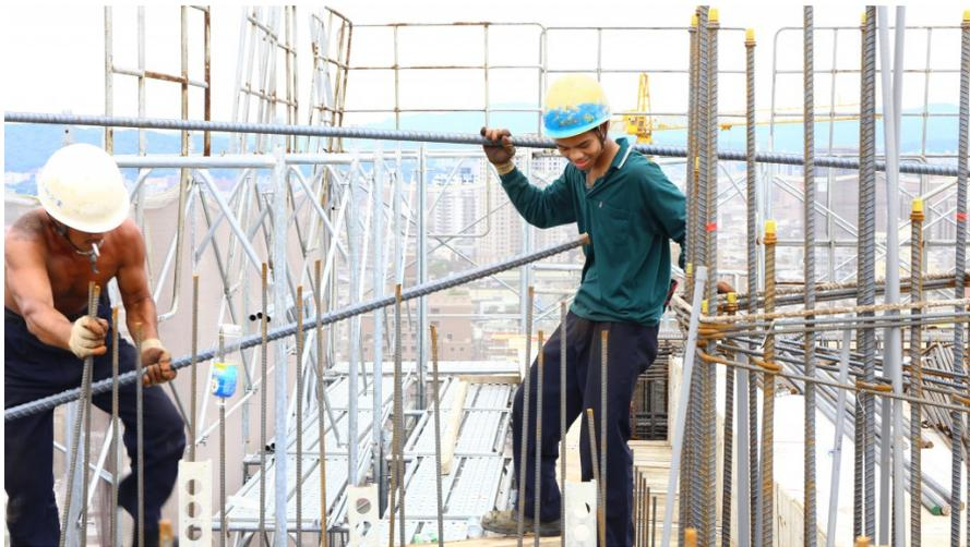
一棟建築物除了地基之外，最重要的即為鋼筋。圖中的鋼筋一條動輒十幾公斤。（照片來源／洪于婷攝）
