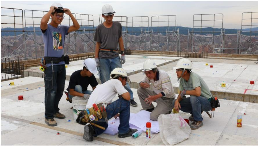
水電師傅必須在鋼筋綁好前，和鋼筋師傅先協調好樓層的水電配置。（照片來源／洪于婷攝）
