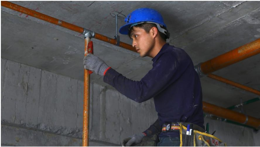
水電工人專注的配置自來水管線，若處理不慎，日後漏水要找出源頭非常麻煩。（照片來源／洪于婷攝）
