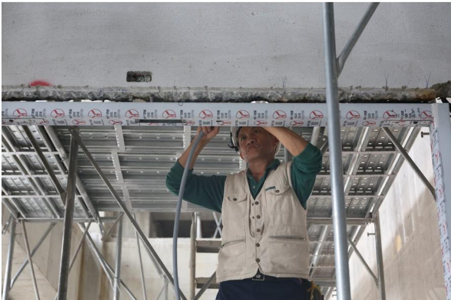
安裝門框的鐵工再三測量水平，以確定鐵門能正確安裝上。（照片來源／洪于婷攝）
