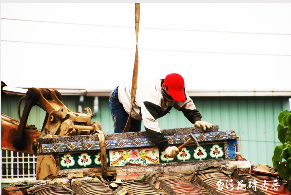
圖為工人要將屋頂挖洞、綁上繩子，以利吊車將鑲有花磚的屋脊吊起。 國立交通大學機構典藏系統版權所有 Produced by IR@NCTU
