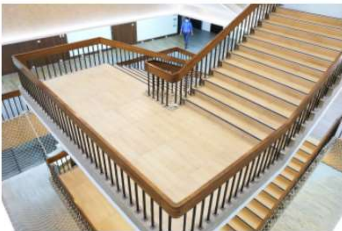
大樓地坪翻新
