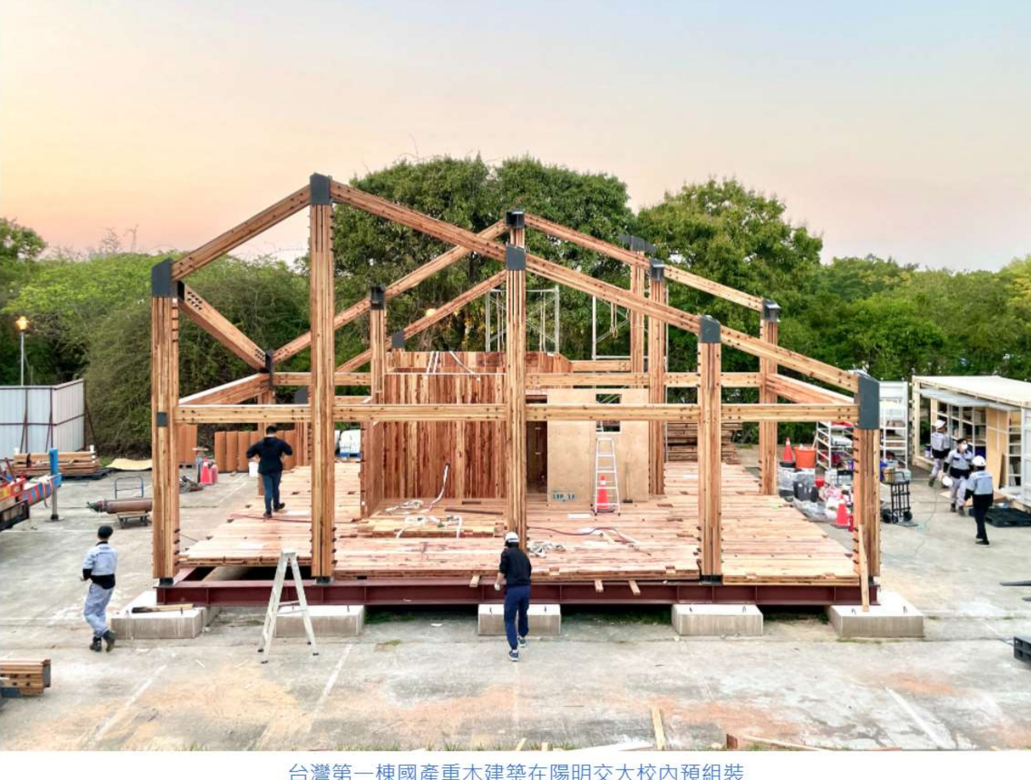
台灣第一棟國產重木建築在陽明交大校內預組裝
