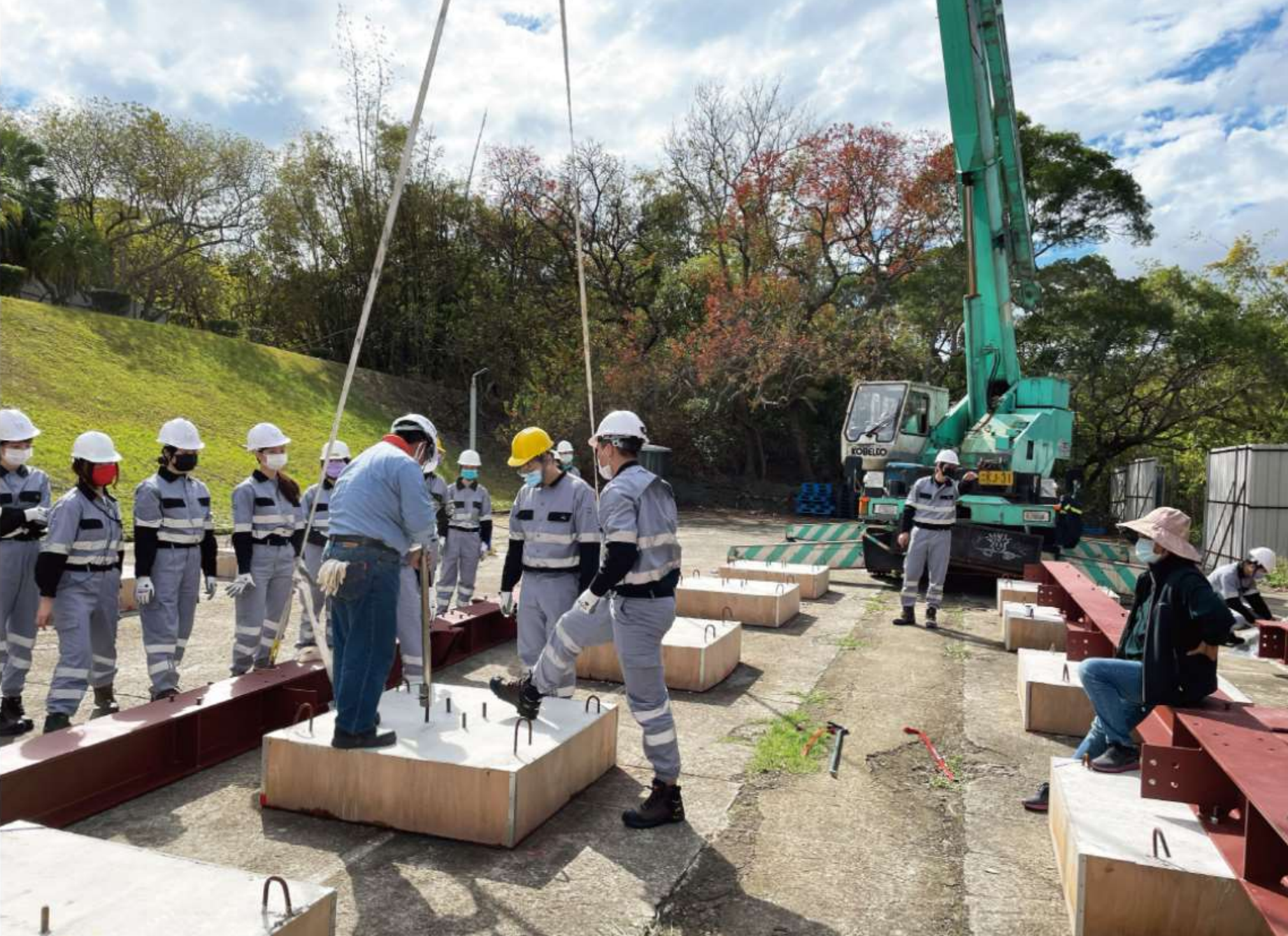
1 House For All 國內預組裝大型機具教學
