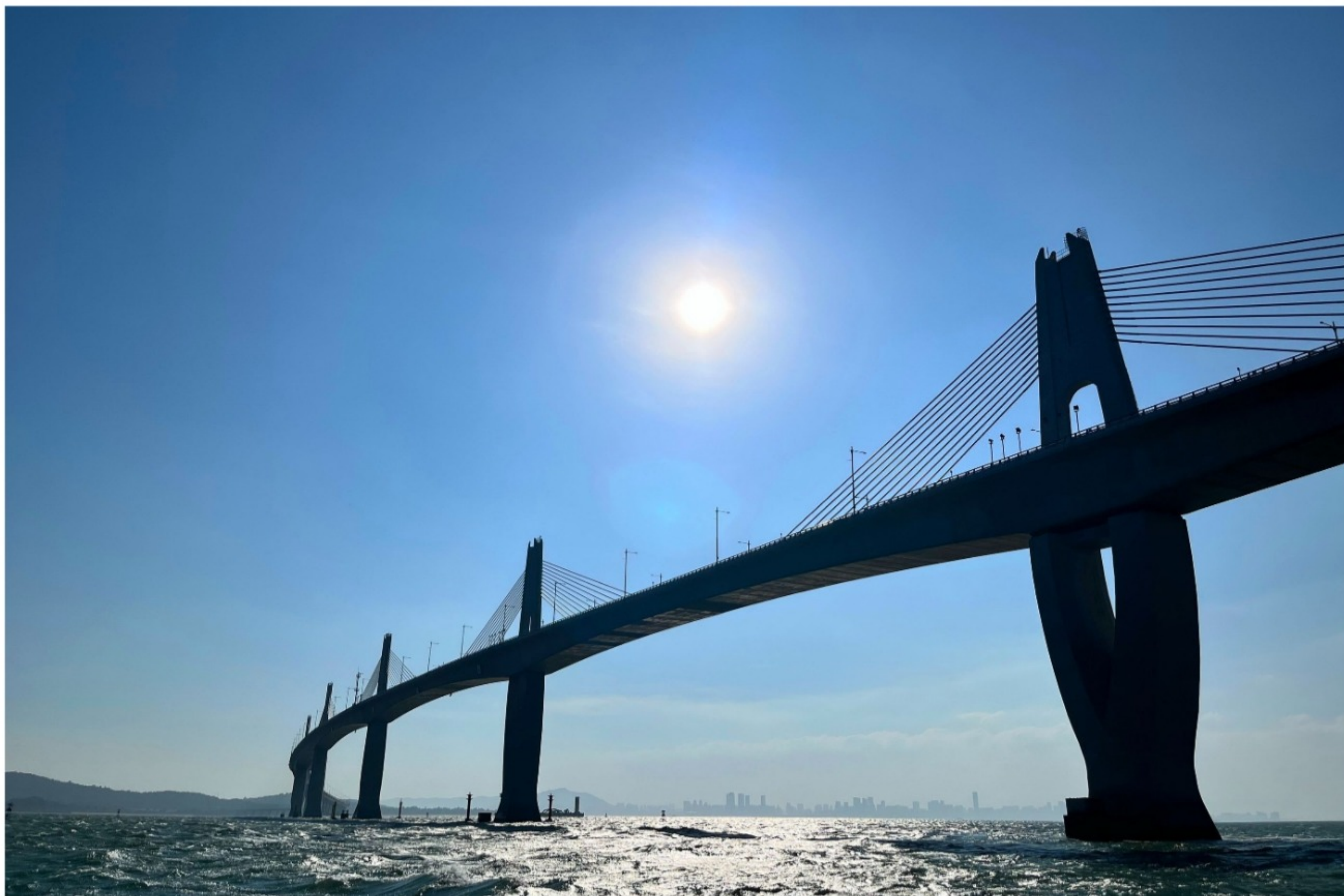
金門大橋是台灣第一座深水域的跨海大橋
