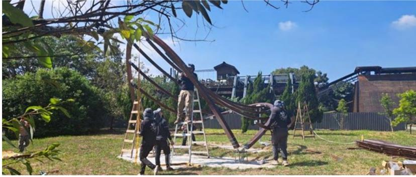
許倍銜說，這幾支主結構雖然長度、曲度都不一樣，卻能夠使用同一個模具，利用演算法取得最佳化的模具形狀，大大減低了建模所需的成本。參數化的設計方式能解放木構造，空間有更多型態不再只是框架，能更簡單的建立曲面，而輕量級也就意味著更佳環保永續的木構型態。
