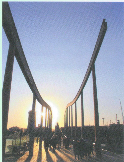
巴塞隆納 威爾港-跨港陸橋
