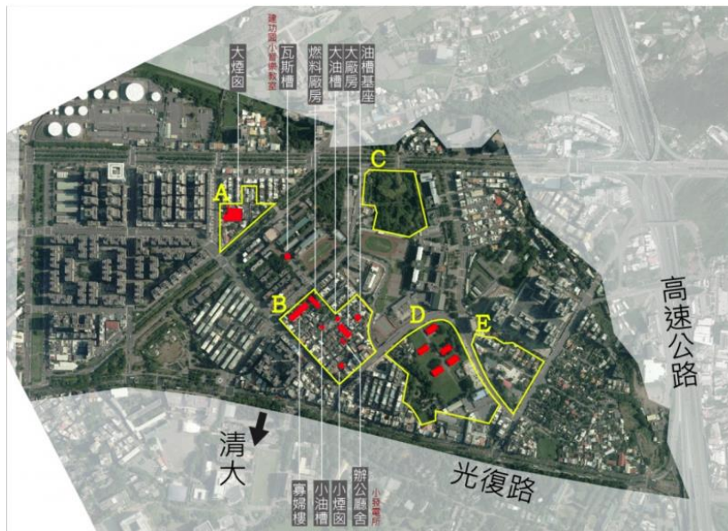
圖 3. 圖中以紅色標方塊代表尚存留的十棟六燃場房建物。D 區的 5 棟觸媒工廠已拆除剩 2 棟。A 區大煙囪下忠貞約 1 公頃 7 ；B 區上忠貞全區 2.3 公頃；C 區地下油庫約 3.2 公頃；D 區觸媒工廠約 1.8 公頃；E 區將軍村約 1.5 公頃。圖片出處：文化部再造歷史現場專案網站 https://rhs.boch.gov.tw/index.php?inter=project&id=1&did=67
