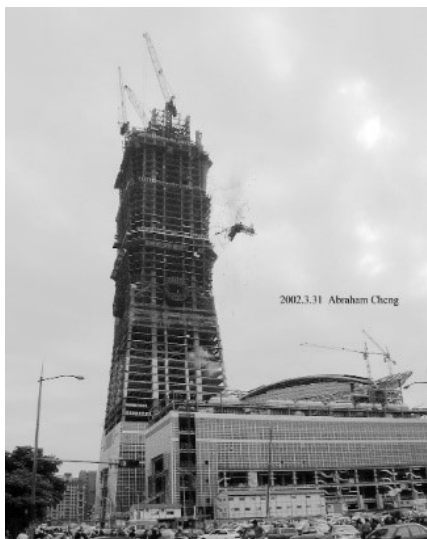
圖 3：331 地震導致兩架塔吊機從二百多公尺高的頂樓工地，連人帶車往下墜落。鄭貴恆攝，2002 年
