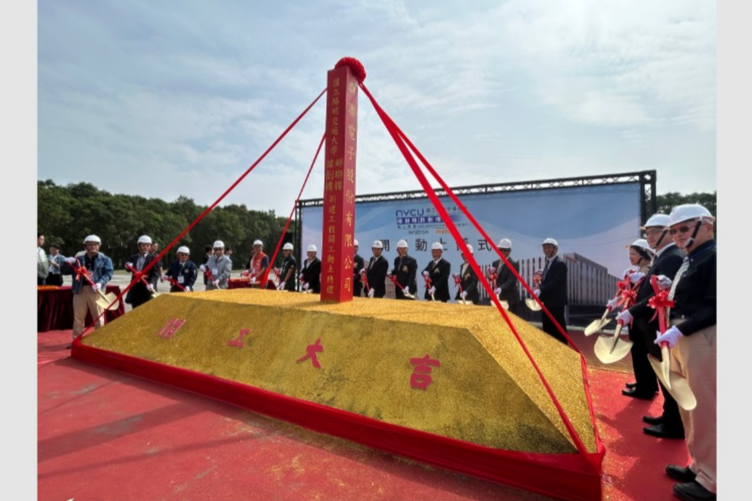
台南校區「群聯樓」與「緯創樓」動土
