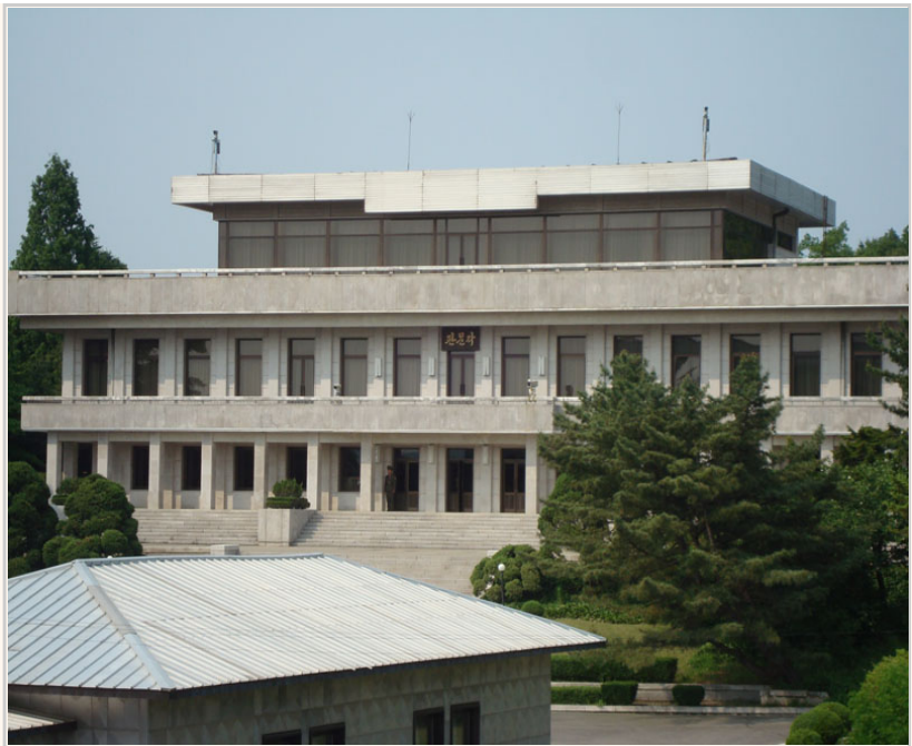
• 朝鮮的板門閣，建築風格稍微復古簡單。
