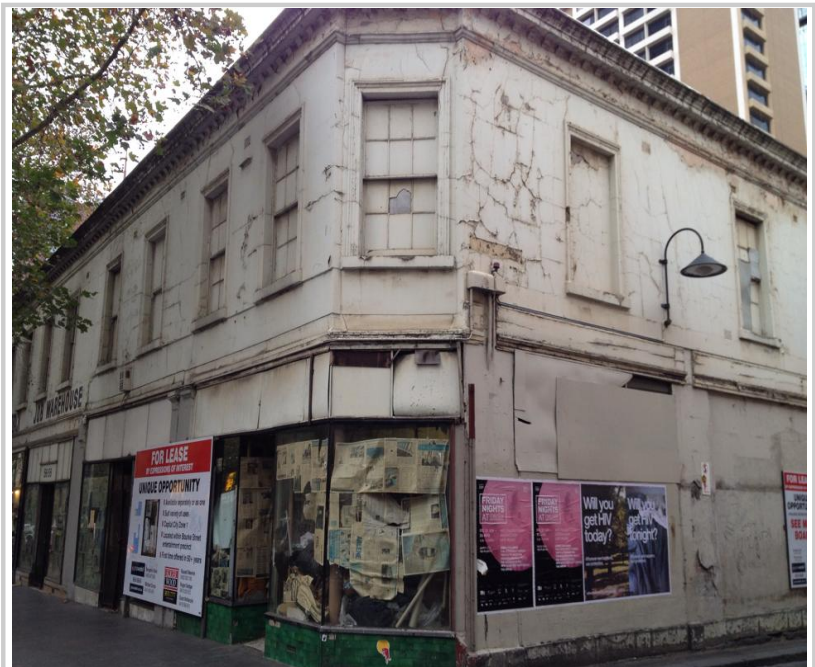
• Crossley Building 目前正在標售
