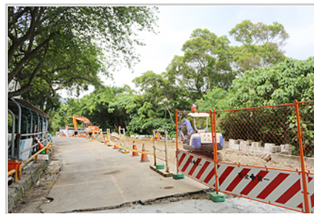
實驗動物中心前方，正在進行工程的路段
