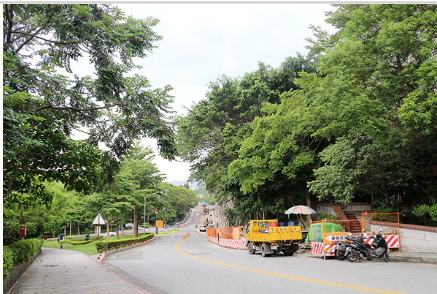
活動中心北側擋土牆施工區域
