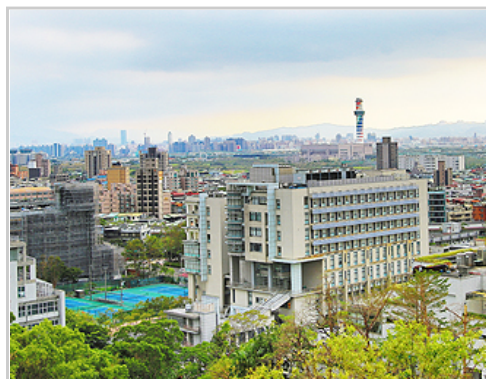
圖資大樓在這次風災受損嚴重 (攝影 / 蔡宗佑)
