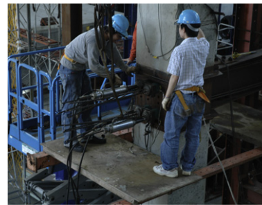
(d) PT beam to column.
