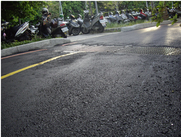
▲美中不足的是，或許是施工單位求好心切，希冀鋪面與排水工程能夠兼顧，於是柏油越鋪越厚，和排水溝的高低差也越來越大。這些在機車E棚前接連出現的長條型坑洞，讓此路段變成學生們最不想經過的「障礙賽道」。
