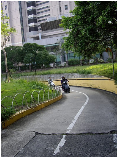
▲平安度過前一段「小山路」之後，緊接而來的是上／下坡路段的大幅度轉彎。車道過窄加上轉彎不及，常常讓機車騎士在此吃盡苦頭，也是事故發生頻率最高的路段。
