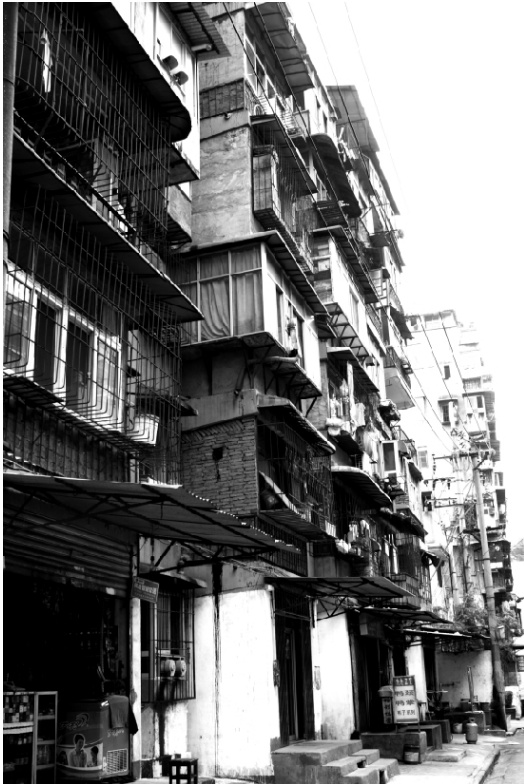
隨著建設開發的腳步，許多早期的加強磚造小區，逐漸面臨被拆遷的命運。
