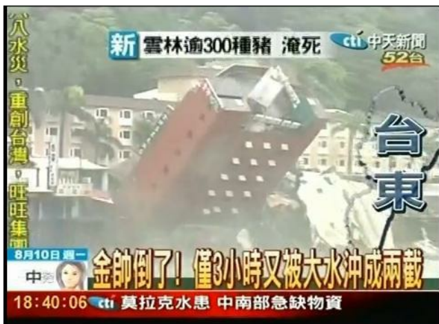
不知被重複播放多少次的知本金帥大飯店倒塌畫面。(資料來源：中天電視台新聞畫面)
