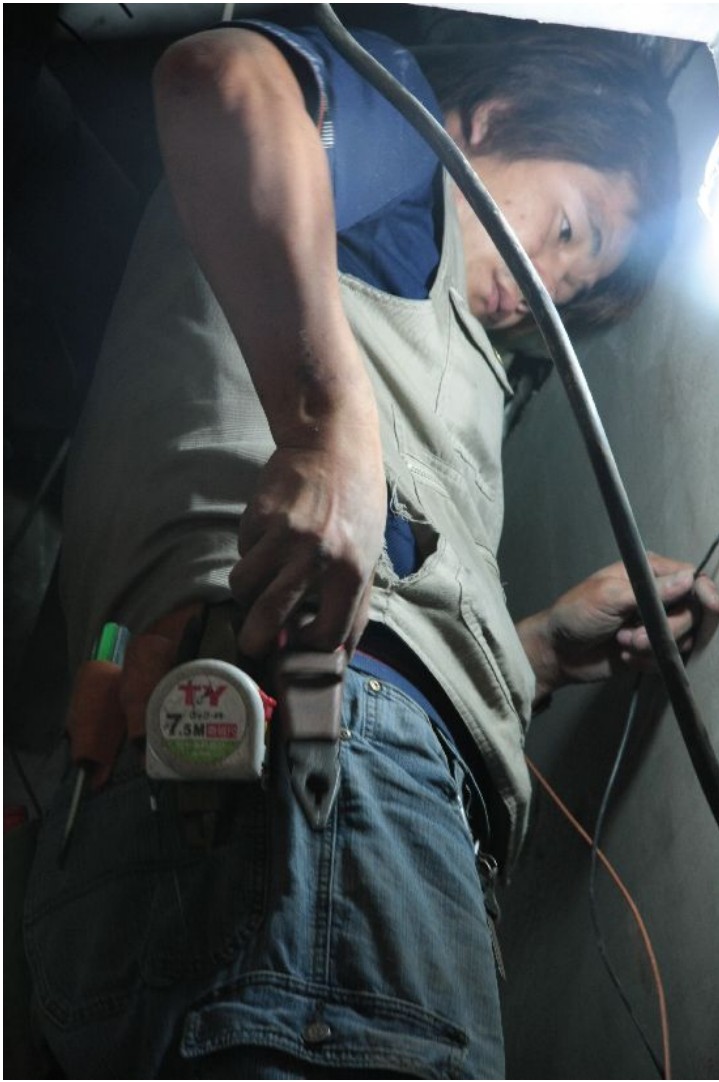
工人正在將整修的廁所加裝電線。(吳奕樺/攝影)
