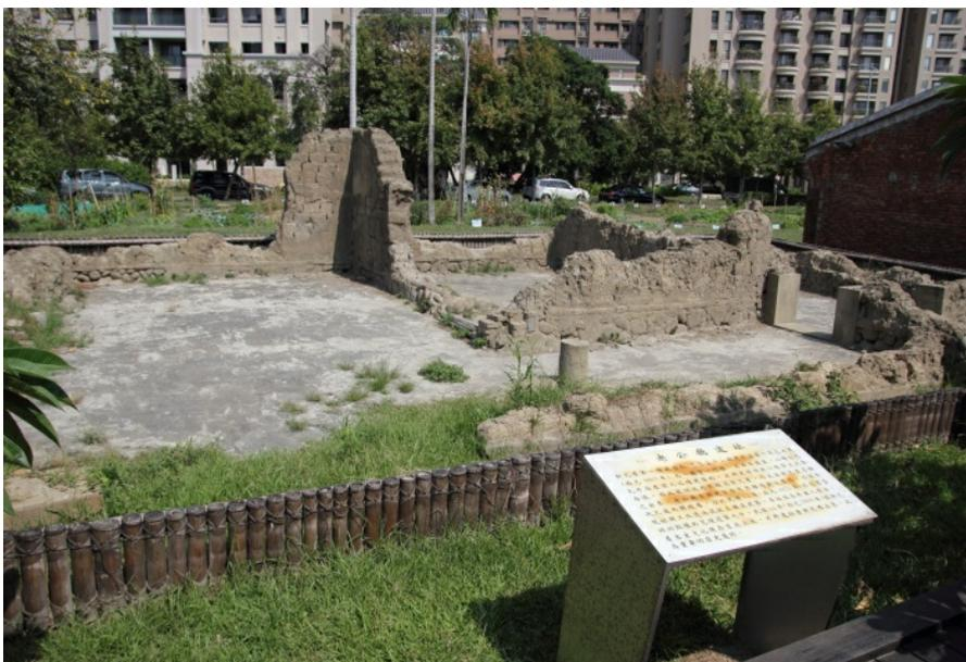
使用泥土、稻稈和稻穀拌和所砌成的泥磚牆，老公廳遺址是新瓦屋的第一棟建築物。(圖片來源/李彥璋 攝)
