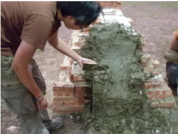
接在燒製陶器後的工作是封窯，封住投柴口並等待窯體冷卻，
