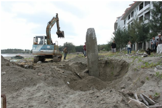
在沙灘上開挖出來的大型水泥塊，美麗灣表示這是舊海水浴場所留下的地基，並非施工廢棄物。
