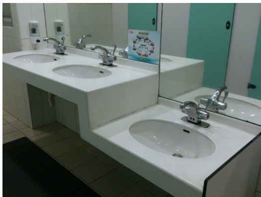
台大兒童醫療大樓廁所設置較低的洗手台，讓小朋友方便使用。（照片來源／戴裕蒞攝）
