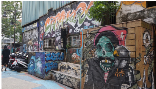
西門町電影公園旁的變電箱、牆壁上充滿美國風格的塗鴉。(照片來源/邱慧真攝)
