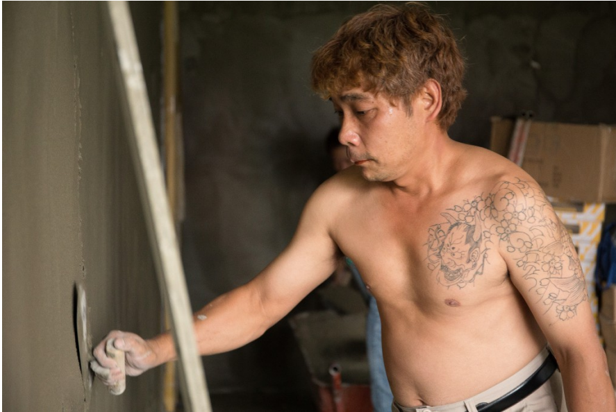
砌泥底的師傅用手持鏟將水泥砌到牆上，再將牆壁拋平滑。師傅說「做泥底很重要，如果牆壁不平順，之後貼的磁磚就會容易掉落」。（照片來源／許鴻財攝）
