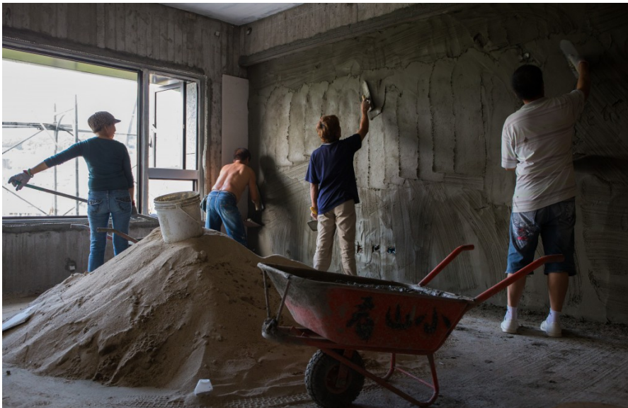
「泥底」是先將水泥攪拌後，再砌到牆壁上，這是在貼磁磚之前需要做的步驟。（照片來源／許鴻財攝）
