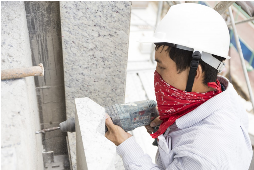
阿杰用電鑽在牆壁上穿孔，之後會將大理石拿上來對位，再用螺絲將大理石與牆壁固定起來。 (照片來源／許鴻財攝)
