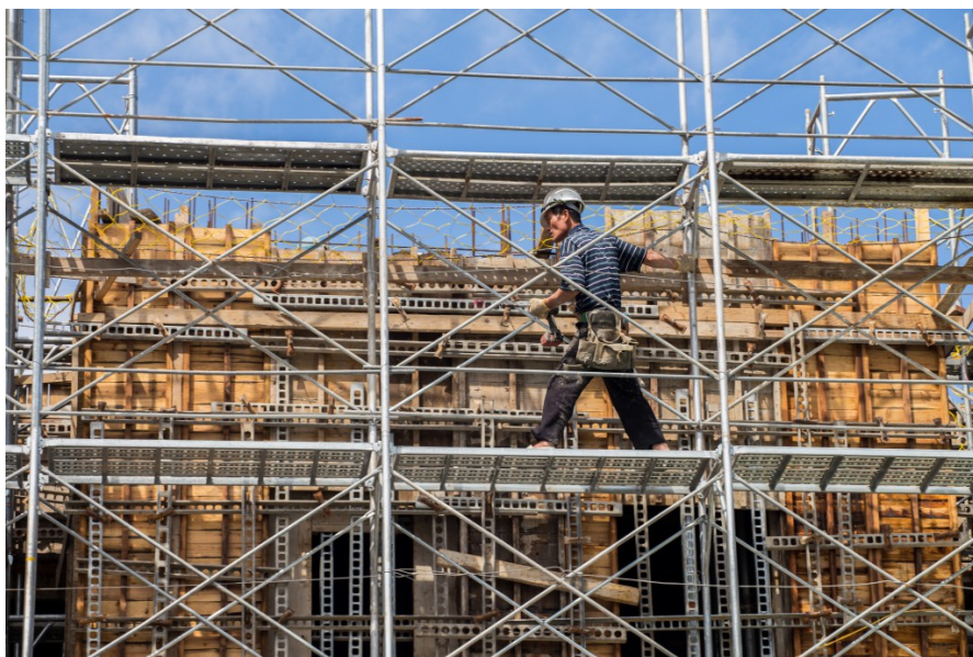
頂著高溫烈日，工地鷹架上的工人熟練地踩在一層層搭起的鐵架上。（圖片來源／許鴻財攝）
