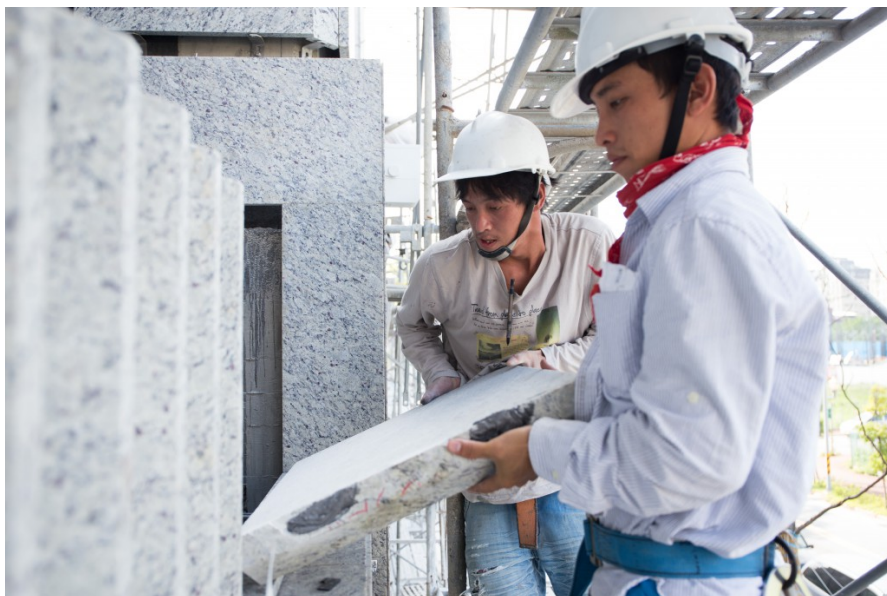
宗哥（圖左）與阿杰（圖右）一起把厚重的大理石一塊一塊的抬到牆壁上。阿杰說：「像這塊就有七十多公斤重，必需要兩個人抬才可以，之前有遇過大概有二噸重的大理石，那就要用機器吊上來。」
