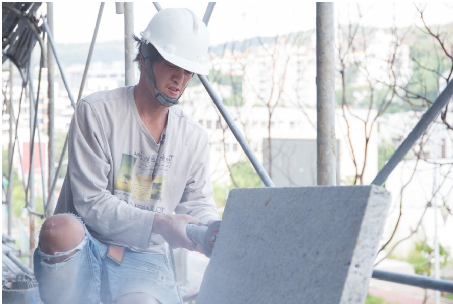
宗哥在鷹架上用電鋸裁大理石的尺寸，宗哥說：「裁大理石每塊大小都要準確，不然又要重新裁，很麻煩。」 (照片來源／許鴻財攝)
