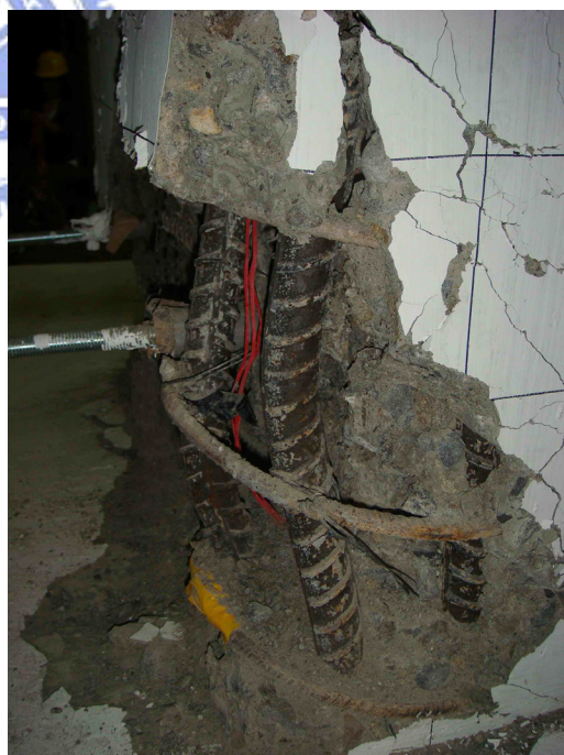
(d) 柱底主筋挫屈變形
