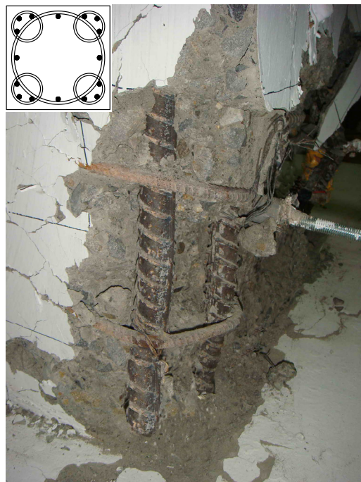
(b) 柱底主筋挫屈變形
