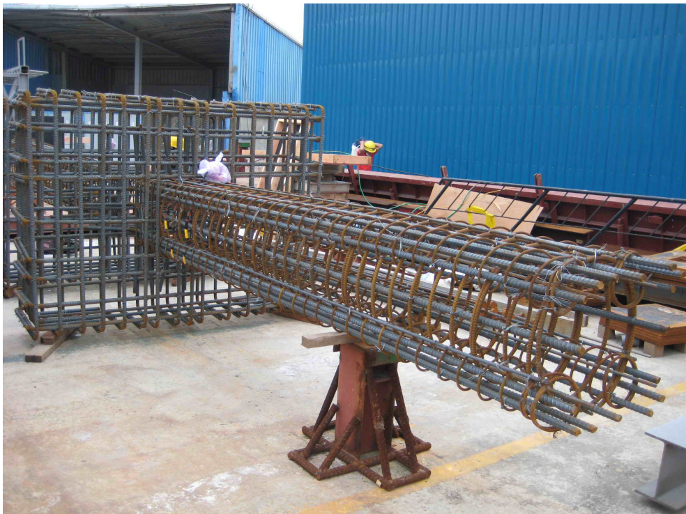
照片 4.1 組立基礎主筋、柱主筋及箍筋
