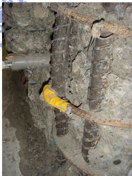
(d) 柱底主筋挫屈變形
