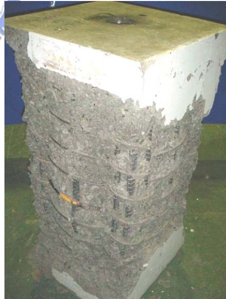
(b) 試體 YW1-S-110 在試驗終止後剝除破裂混凝土之破壞情形
