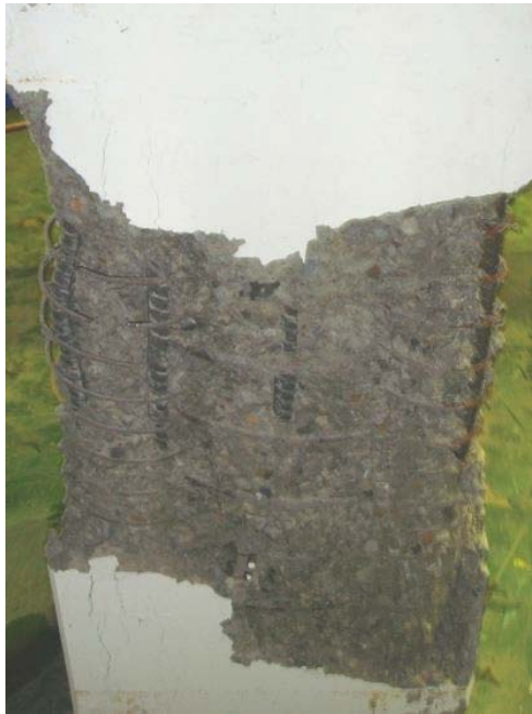
(a) 試驗終止且剝除破裂混凝土後之情形
