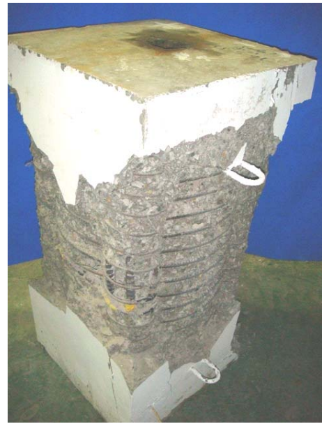
(b) 試體 YW2-S-55 在試驗終止後剝除破裂混凝土之破壞情形
