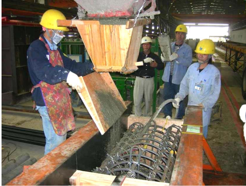
照片 3.4 五螺箍短柱試體進行灌漿與搗實作業之情形
