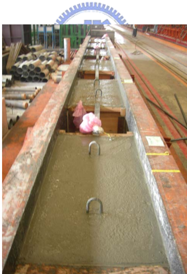
照片 3.5 五螺箍短柱試體灌漿完成之情形
