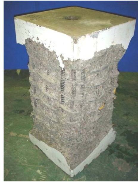
(b) 試體 Y9-M-120 在試驗終止後剝除破裂混凝土之破壞情形
