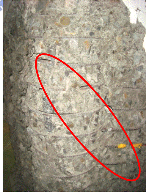
(b) 大、小螺箍呈斜線狀連續性斷裂
