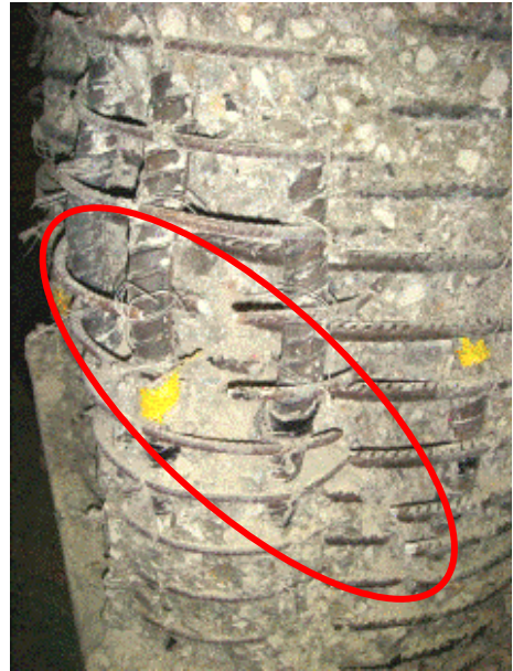
(b) 大、小螺箍呈斜線狀連續性斷裂
