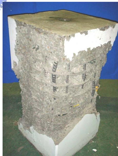
(b) 試體 YW7-L-95 在試驗終止後剝除破裂混凝土之破壞情形
