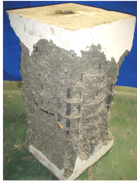
(b) 試體 YW10-M-110 在試驗終止後剝除破裂混凝土之破壞情形
