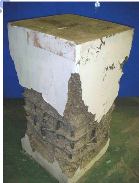
(b) 試體 R1-120 在試驗終止後剝除破裂混凝土之破壞情形
