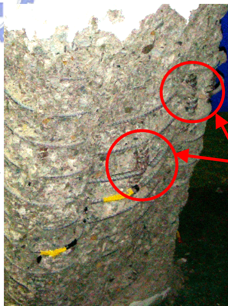
照片 3.9 大、小螺箍皆斷裂之破壞模式 (試體 Y8-M-75, 箍筋間距為 75 mm, 大、小螺 箍線徑分別為 D13 與 D10)
