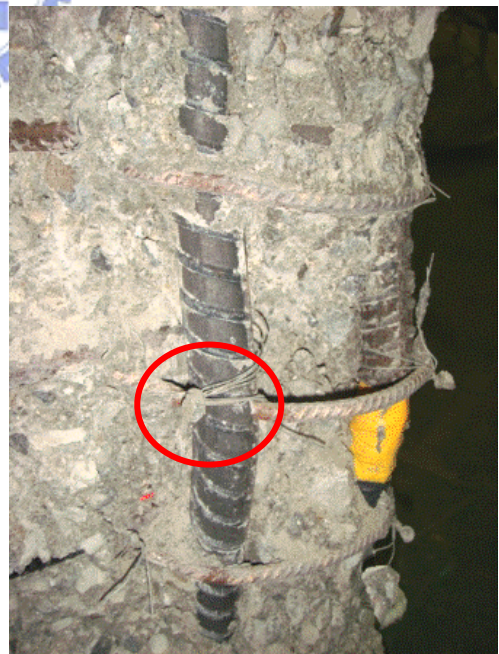
(b) 大、小螺箍交集處之小螺箍斷裂
