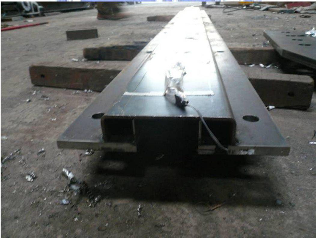
照片 3.12 長槽形鋼構件點焊於面板
