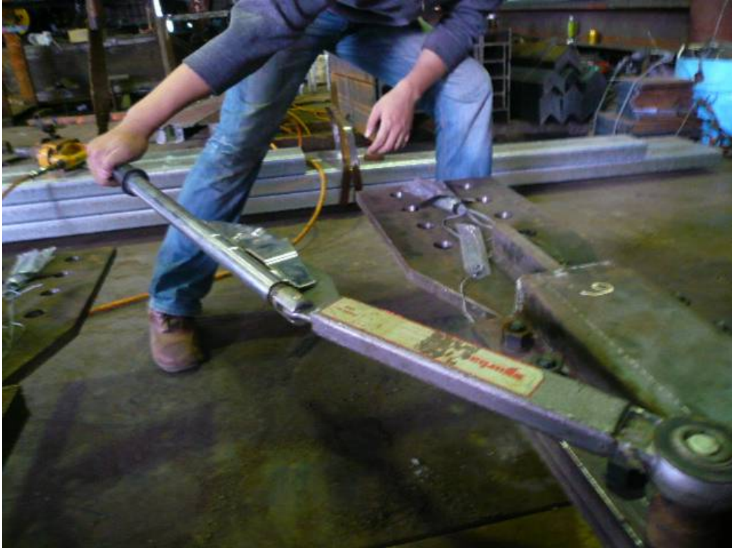
照片 3.9 扭力扳手將螺栓鎖至預緊軸力
