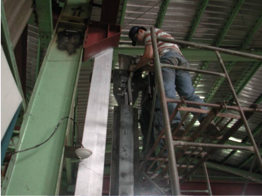
照片 3.15 圍束構件內部澆置無收縮水泥砂漿
