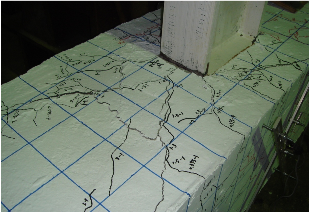
照片 4.33 試體SR0.6-R6 混凝土有明顯開裂隆起 (4% drift)
