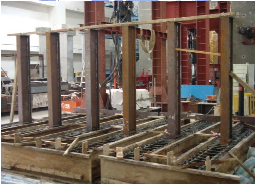
照片 3.2 模板組裝作業
