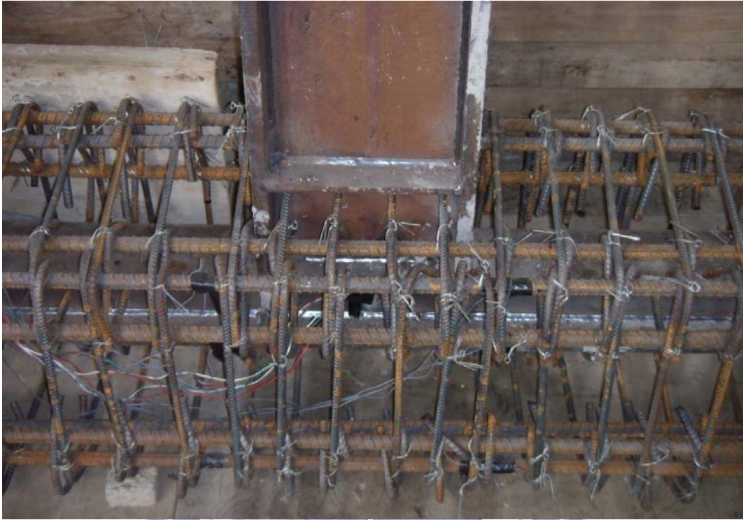
照片 3.1 鋼骨與鋼筋之組合
