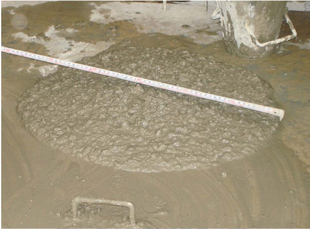
照片 3.3 自充填混凝土坍流度試驗 (55~65 cm)
