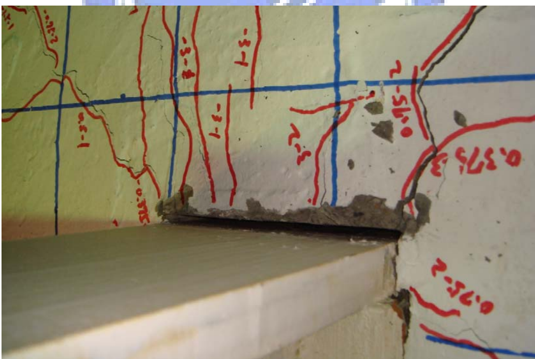
照片 4.16 試體SR0.4-R8 鋼梁翼板周圍混凝土被擠壓約 2 mm 間隙 (3% drift)
