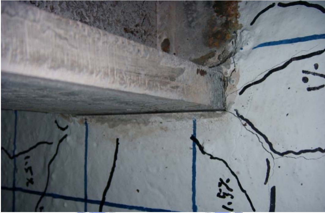
照片 4.3 試體SR0.8-R8 鋼梁翼板周圍混凝土被擠壓約 1 mm 間隙 (3% drift)
