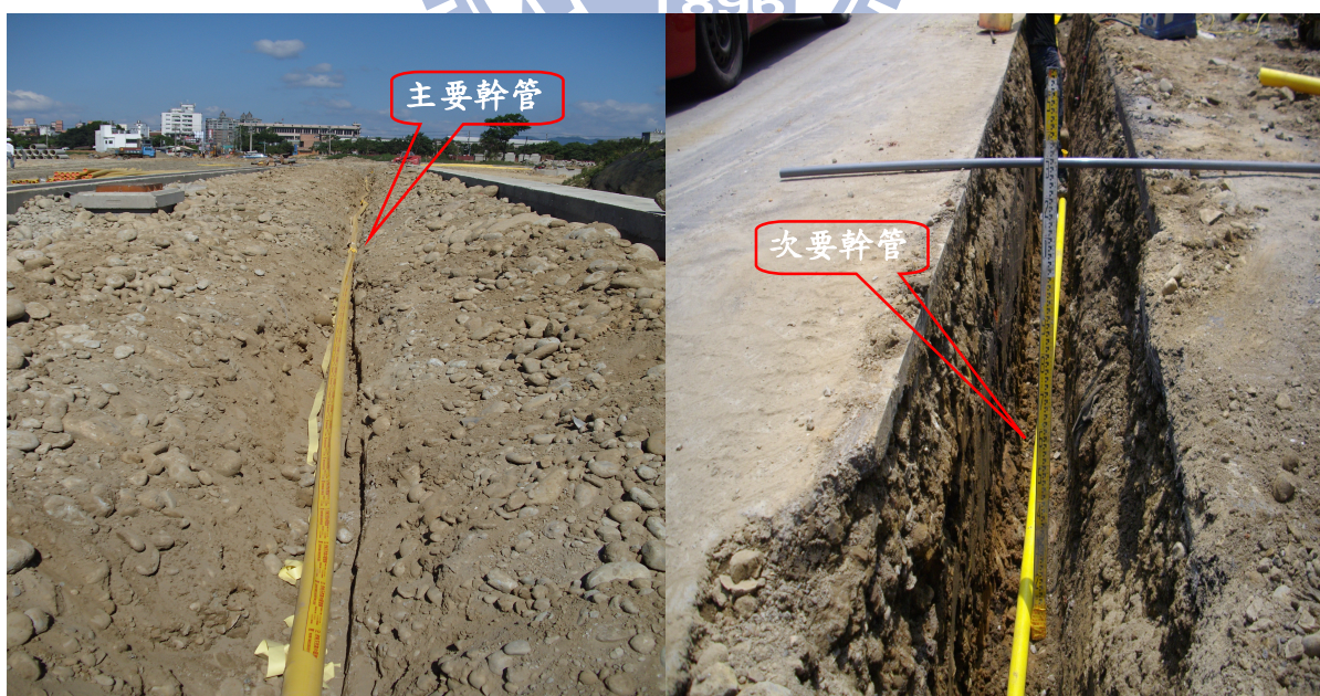
圖 3-2 外管工程之主要幹管及次要幹管
