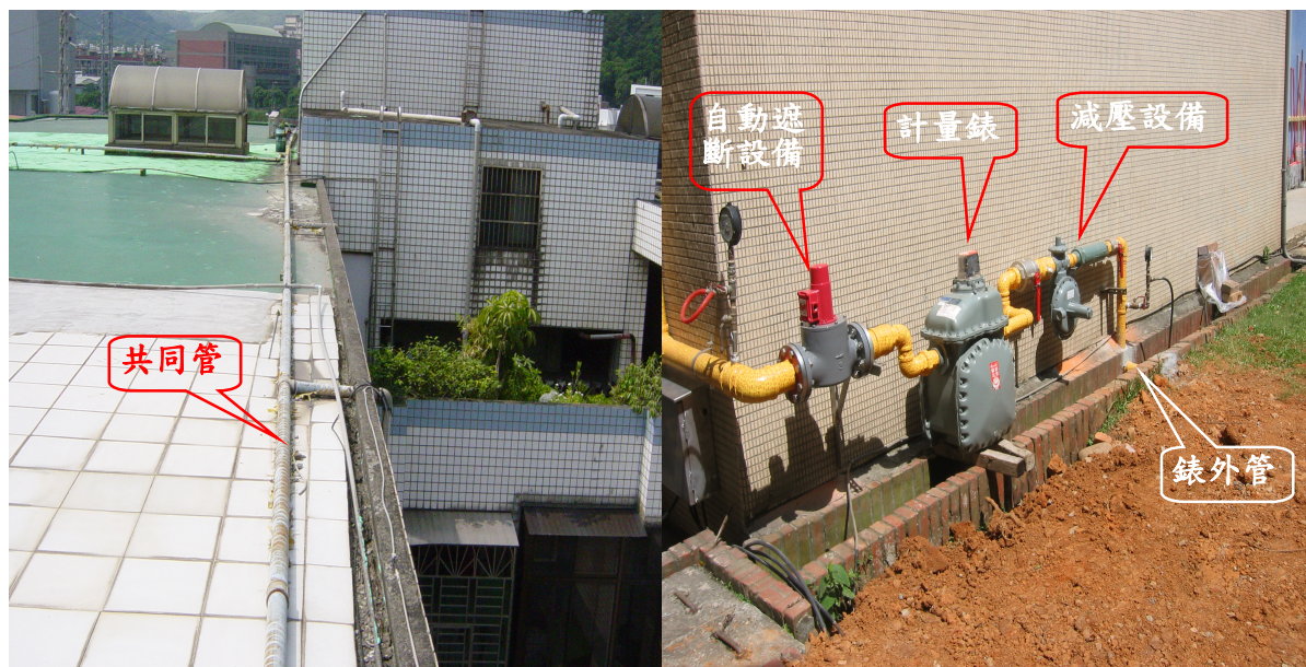
圖 3-1 內管工程之共同管及錶位
