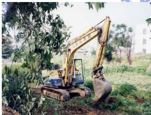
圖十七：怪手整地填土
