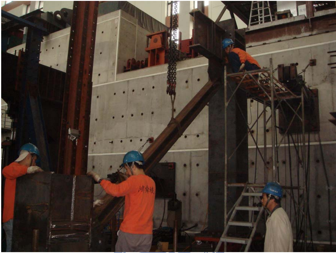
圖 4.22 斜撐構材吊裝
